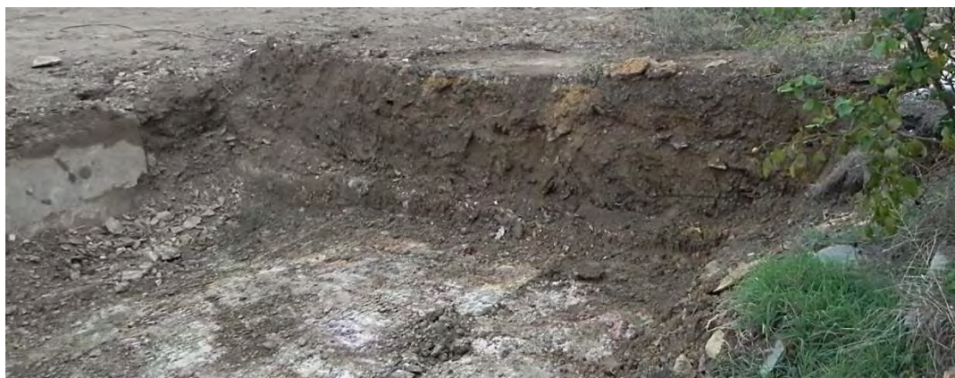
Perfil con relleno de tierra bajo la calle. A la izq. Panteón Familia Gómez.
