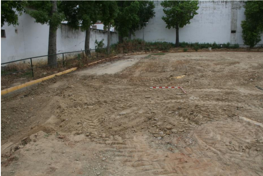
Estado actual después de haber rellenado con tierra el sondeo para localizar la fosa en el sector Suroeste.
