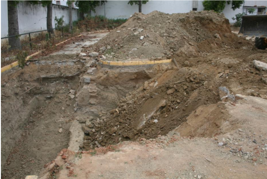
Detalle de la cubrición de la fosa en el sector Suroeste.
