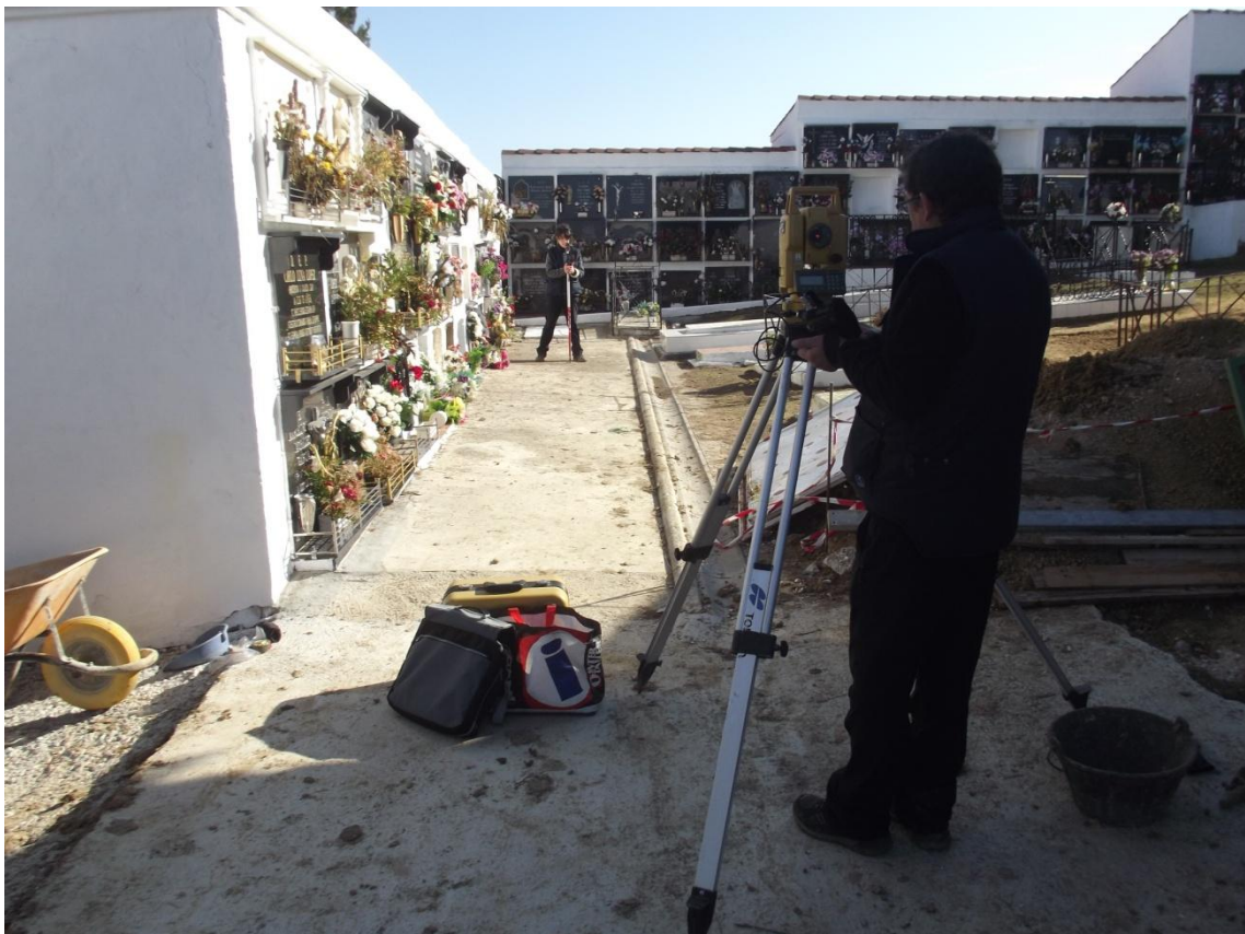
Detalle de los trabajos topográficos.
