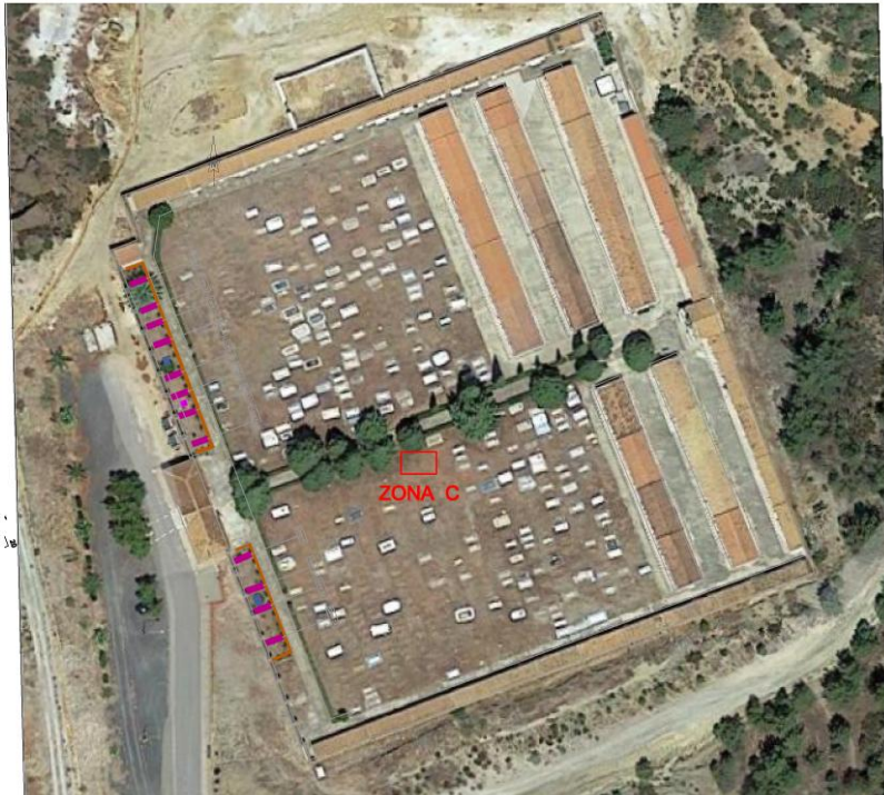
Figura 15. Localización zona C.
