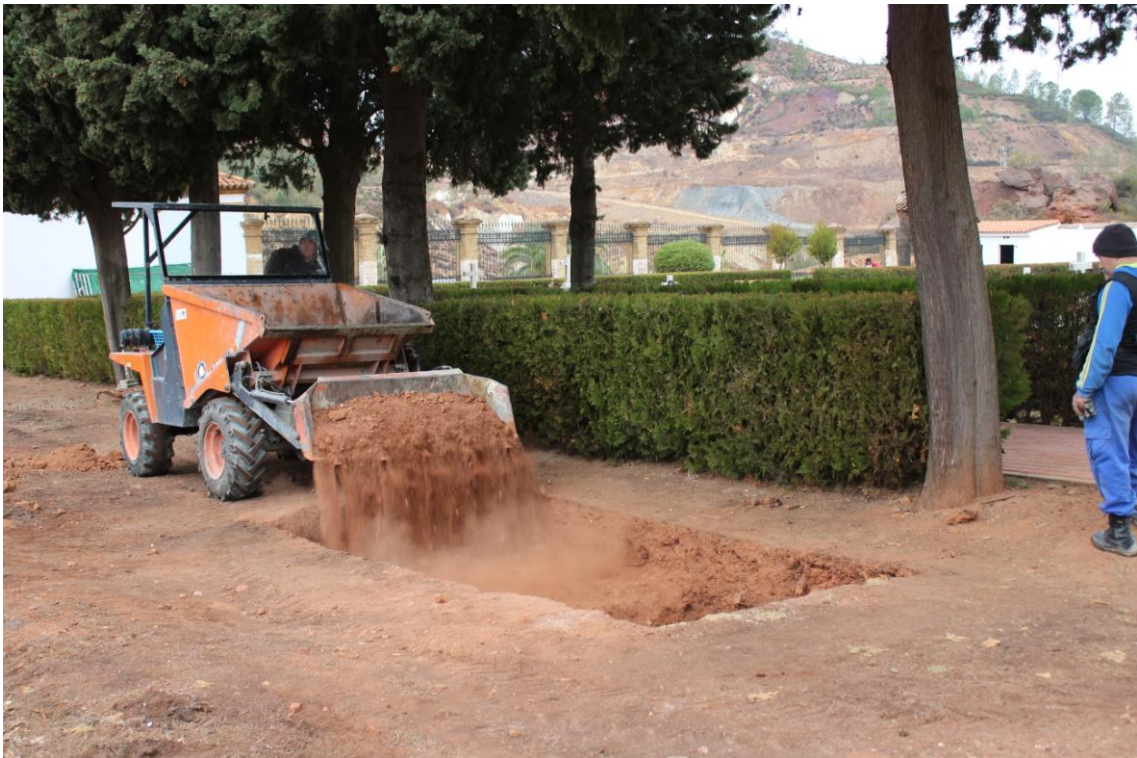
Lámina 33. Trabajos de cubrición del sondeo 1.
