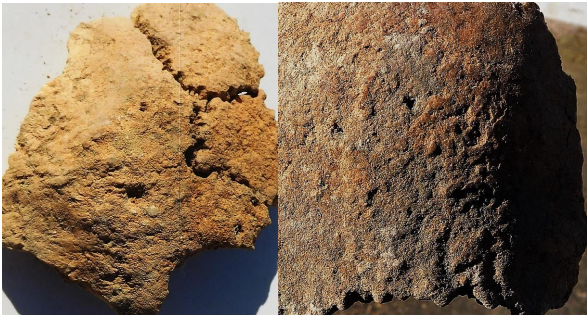
Deterioro de la tabla externa por la acción del agua, con disolución del tejido compacto
