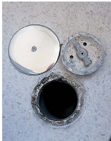
10. Bote sifónico con tapa desmontada.
