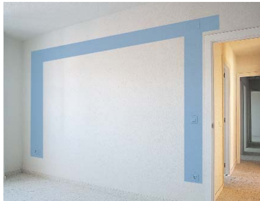
24. Bandas por donde discurren las instalaciones. Salón.
