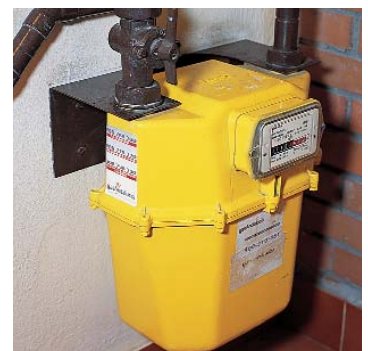
21. Contador individual y llave de corte.
