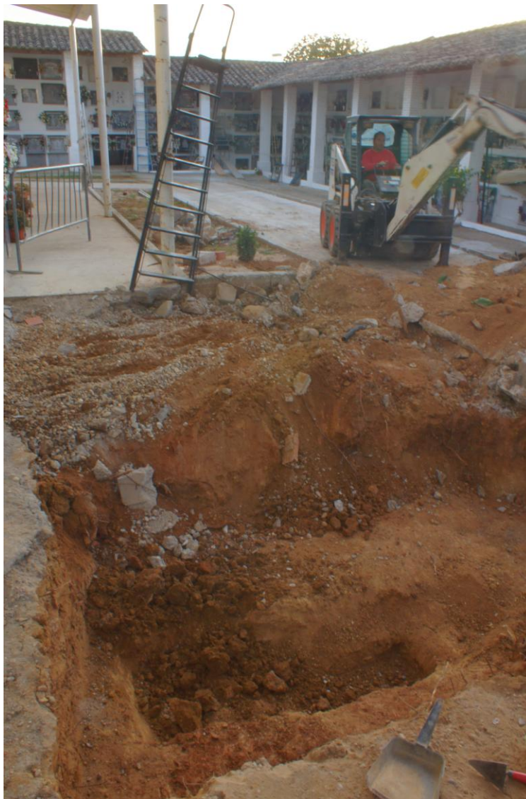
Detalle de los trabajos mecánicos
