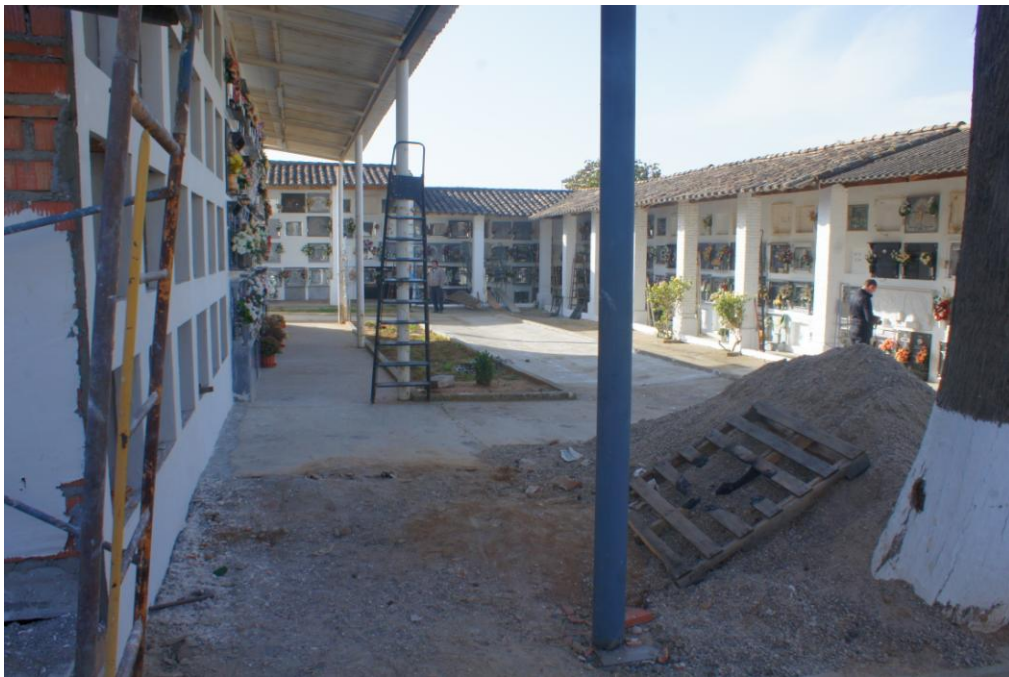
Zona de actuación antes de iniciar los trabajos. Perspectiva Norte
