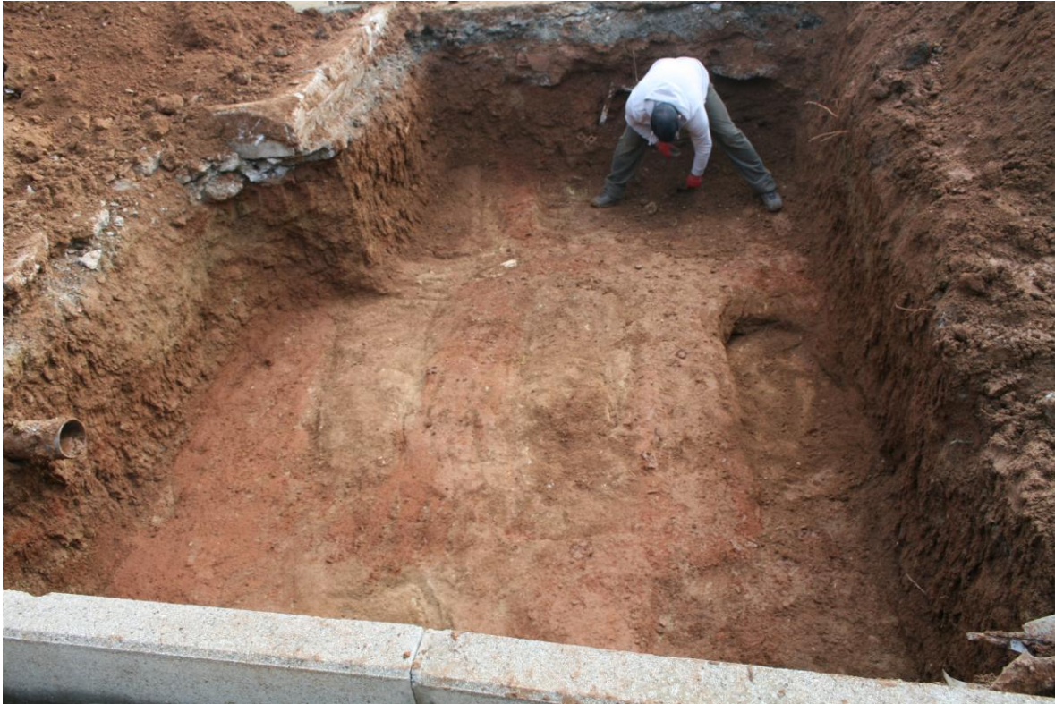
Detalle de los trabajos manuales en planta
