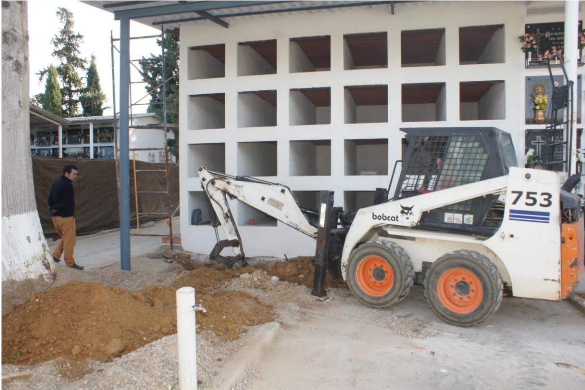
Detalle de la retirada de tierra mecánicamente
