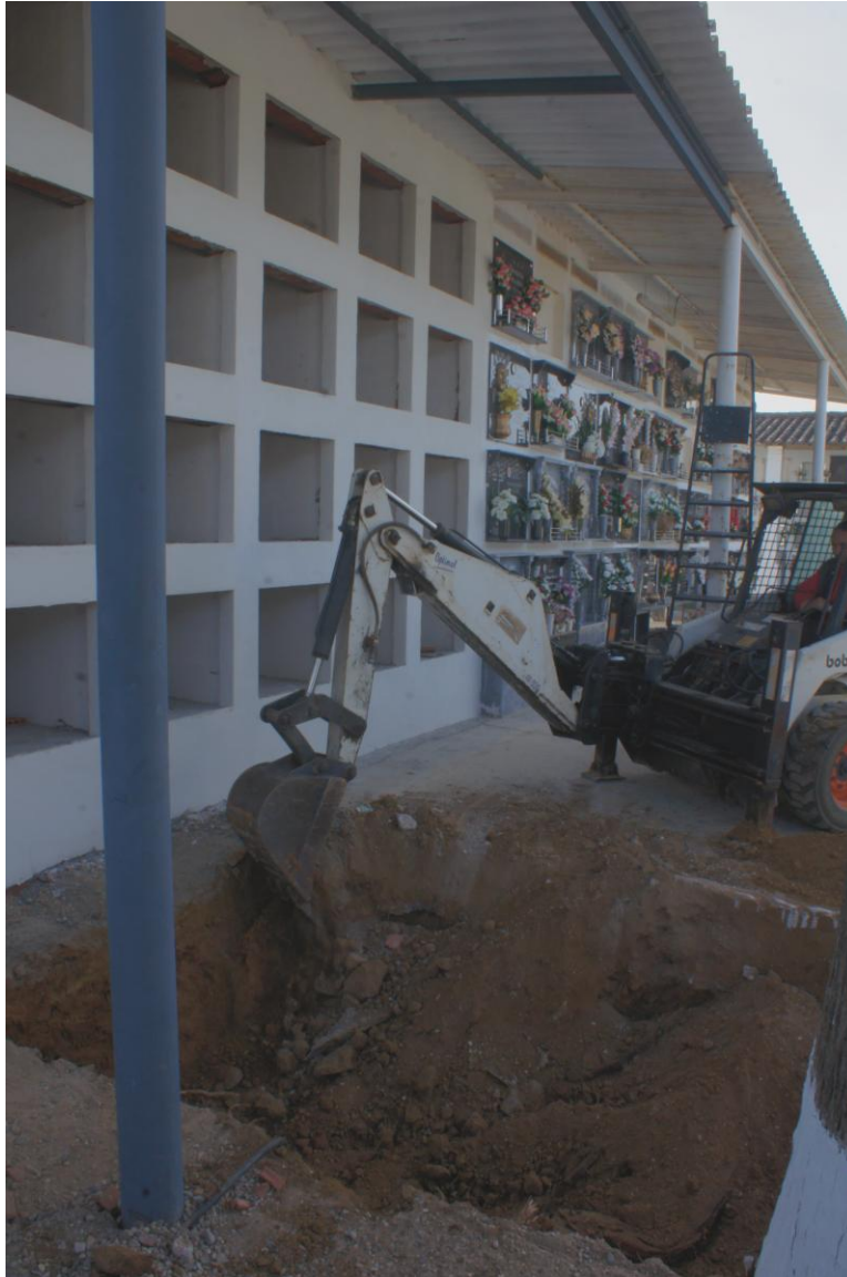
Detalle desarrollo de los trabajos mecánicos
