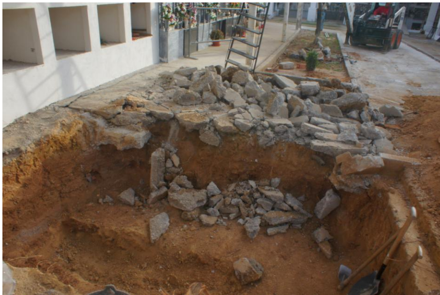
Retirada de hormigón
