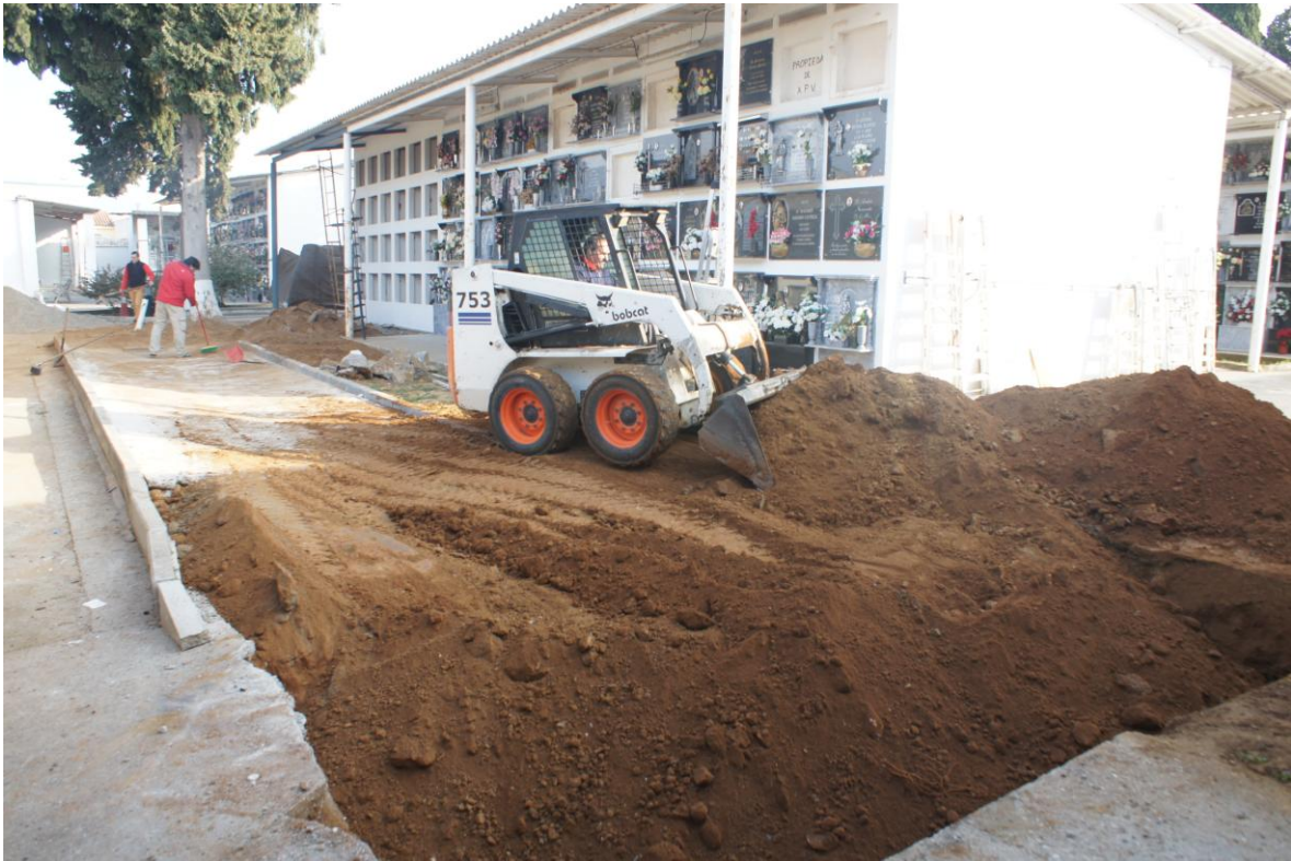
Detalle de los trabajos de cubrición del sondeo 3
