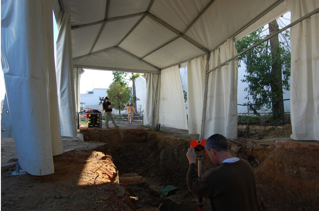
Trabajo topográfico en la zona de actuación.
