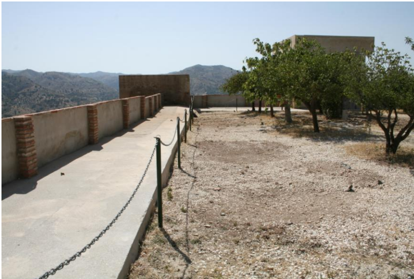
Foto. Estado final después de la cubrición de las catas.
