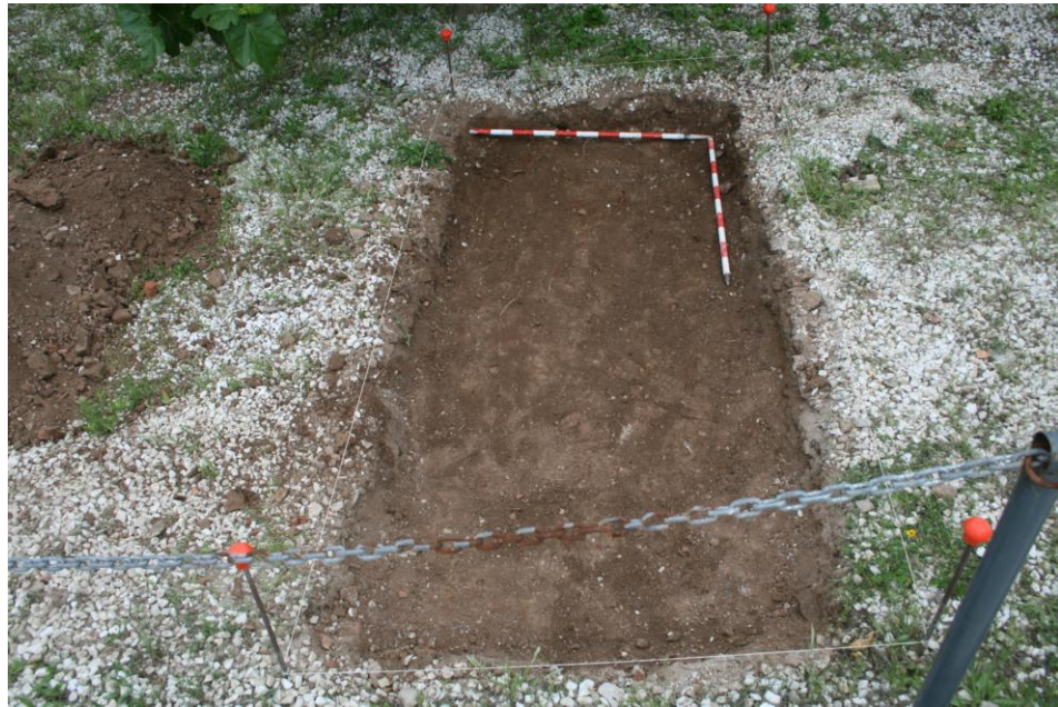
Foto. Primer rebaje manual en la cata 3.
