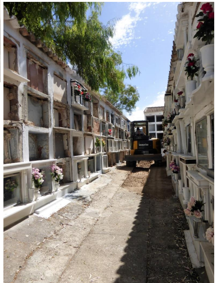
Finalización de los trabajos de la cata en el sector Norte. La cata se ha vuelto a cubrir con la tierra extraída.
