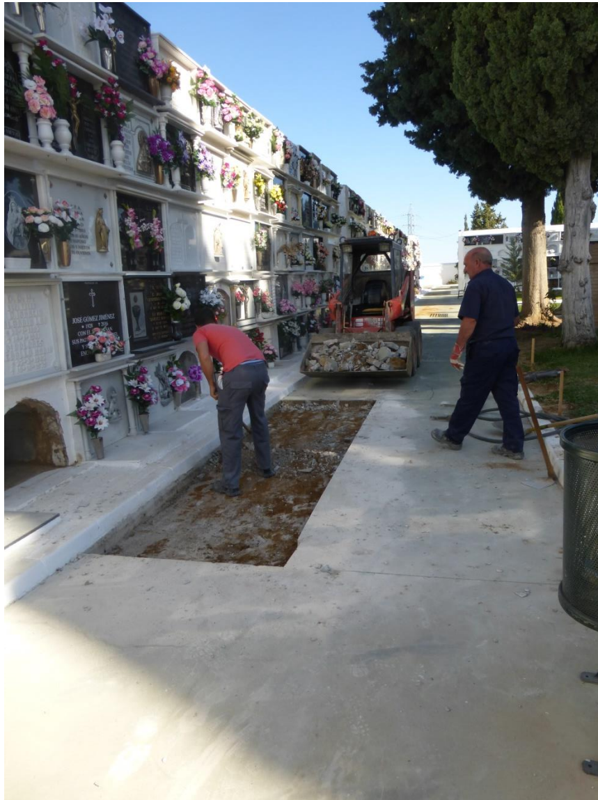
Apertura del Sondeo 4 junto a los bloques de nichos.
