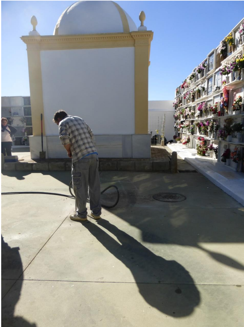
Inicio de la apertura del Sondeo 2, delante de los bloques de nichos y a la derecha del Panteón de la familia Candau.
