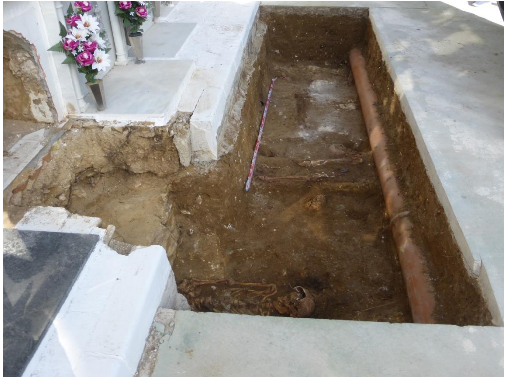
Excavación del sondeo 4 y cata de ampliación hacia el nicho 334 para comprobar la cimentación.
