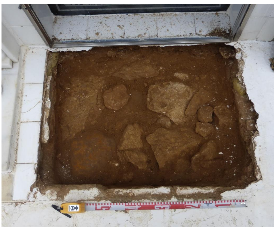
Ejecución de la cata para la comprobación de la cimentación de los bloques de nichos. Se constata que la cimentación es del mismo tipo que la documentada en el sondeo 4, piedras de calizas y albero unidas con un mortero de cal y tierra. Sobresale de la pared de los nichos 0,60 m, ocupando todo el acerado.
