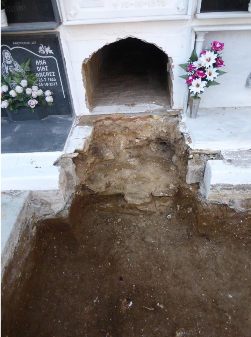
Ampliación del sondeo 4 hacia el acerado de los bloques de nicho junto al nicho 334.
