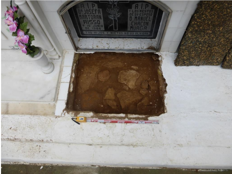
Ejecución de la cata para la comprobación de la cimentación de los bloques de nichos. Se constata que la cimentación es del mismo tipo que la documentada en el sondeo 4, piedras de calizas y albero unidas con un mortero de cal y tierra. Sobresale de la pared de los nichos 0,60 m, ocupando todo el acerado.
