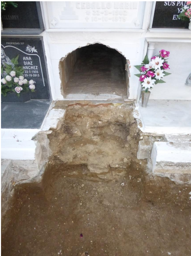
Excavación del sondeo 4 y cata de ampliación hacia el nicho 334 para comprobar la cimentación.
