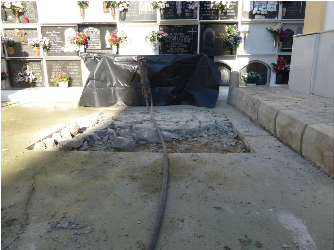
Inicio de la apertura del Sondeo 1, retirada de la solera de hormigón para proseguir con la excavación manual.
