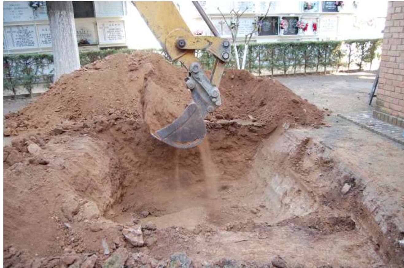
Continuación de los trabajos en el Sondeo 4.
