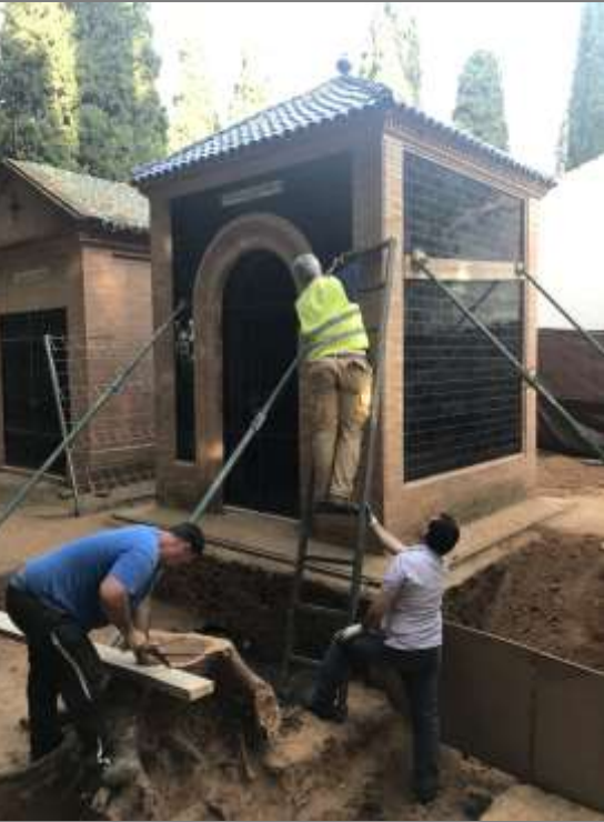
Trabajadores municipales procediendo al apuntalamiento del Panteón familiar de Alberto de la Hera.
