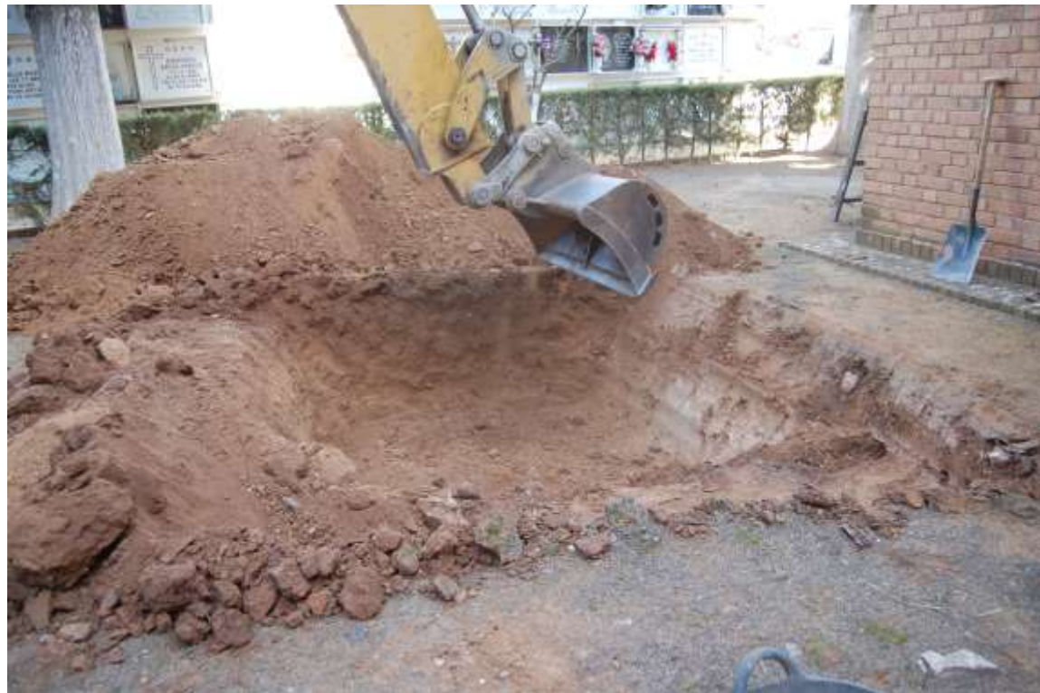
Inicio de los trabajos en el Sondeo 4.
