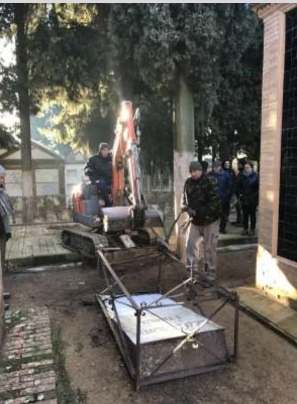
Inicio de los trabajos. Retirada de estructuras
