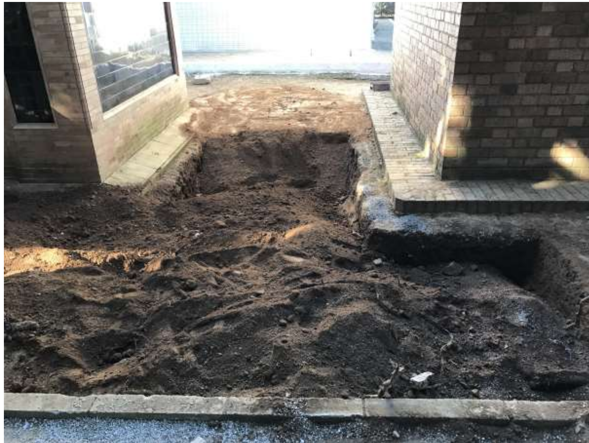
Fosa 1. Protección de los restos y reposición a su estado original.
