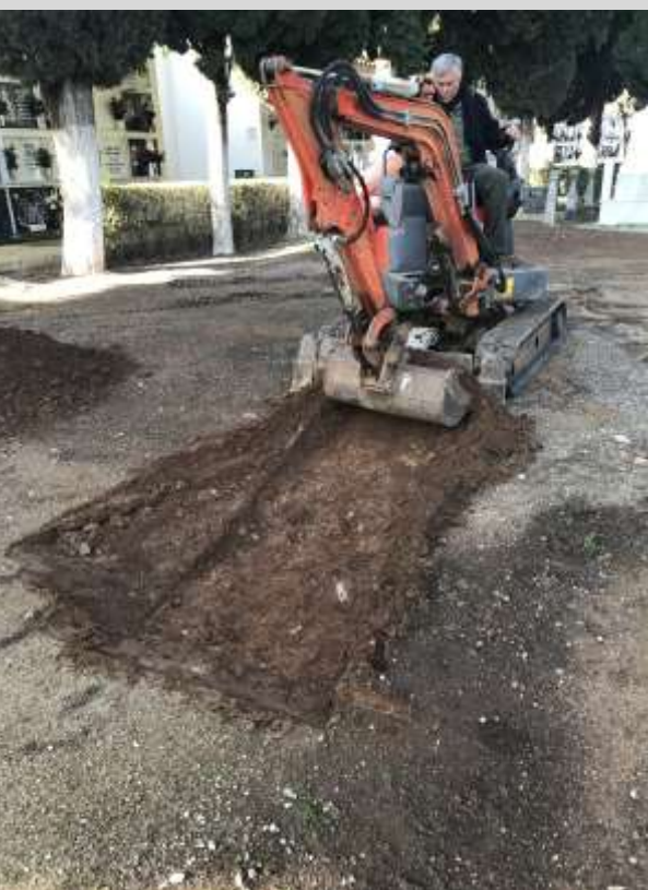
Inicio de los trabajos en el Sondeo 3.
