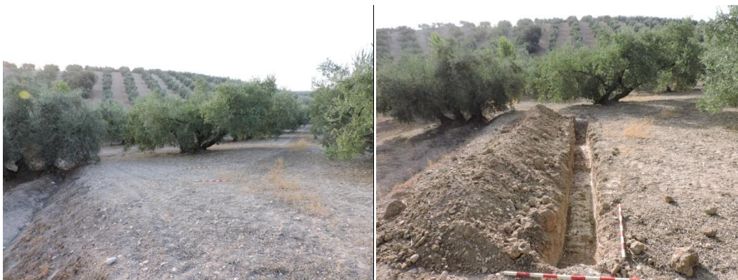
Lámina. Detalle de los trabajos en finca Cubero durante las tareas de localización.
