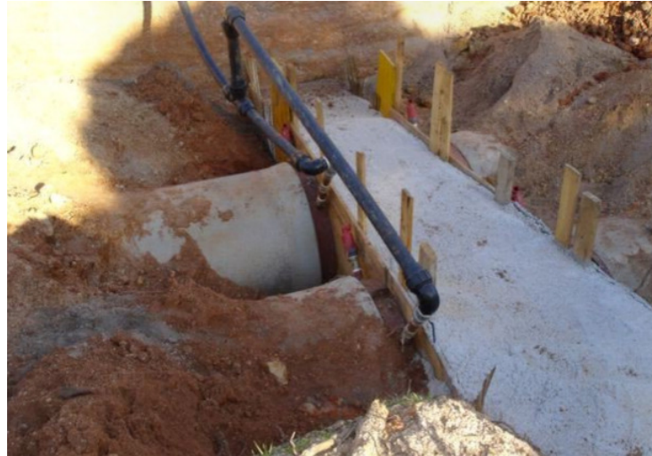
Imagen 15. Obras en curso del Proyecto de Mejora del Fresno.
