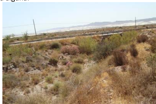
Rambla de Ródenas a su paso bajo la carretera AL-3108.
