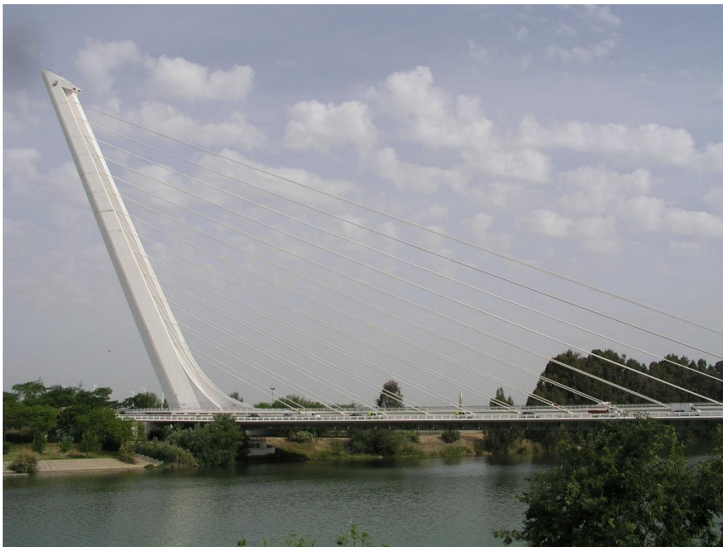
Imagen 20. Puente del Alamillo
