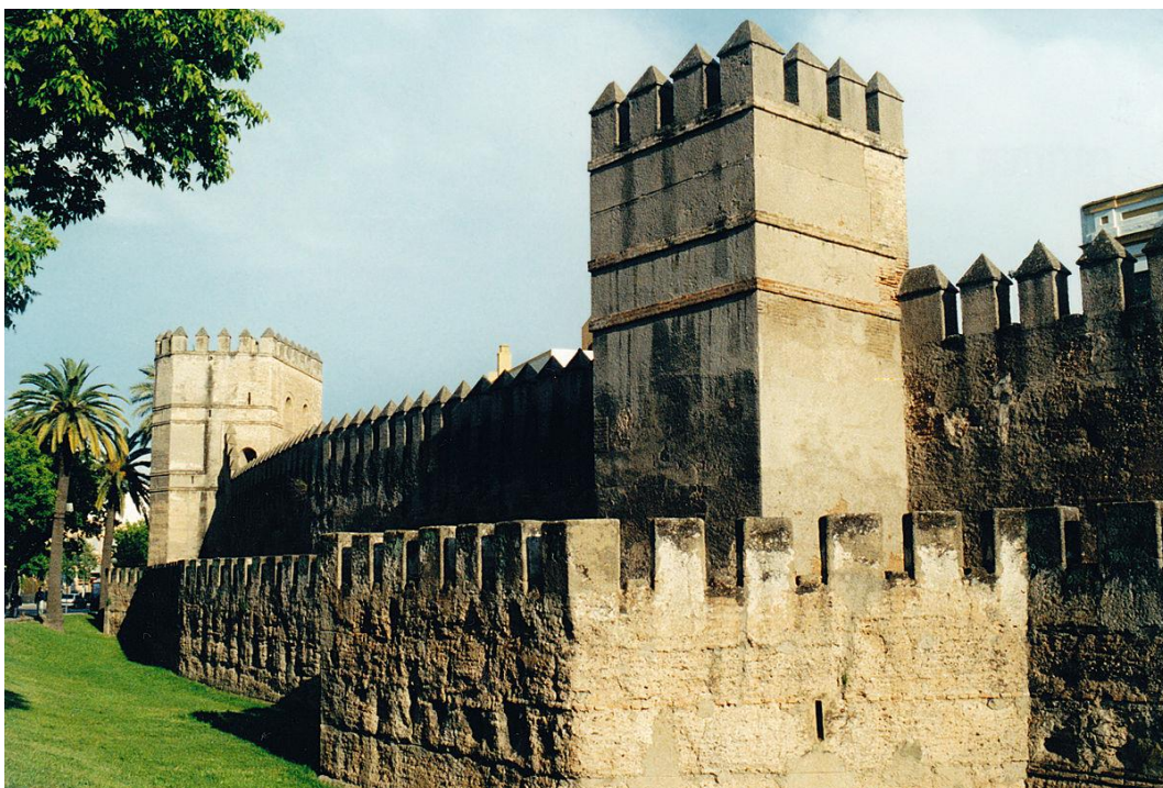
Imagen 19. Muralla almohade de la Macarena
