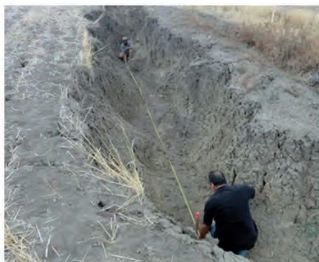
Medida de la distancia entre diques con cinta métrica. Las estacas definen la posición de los mismos.
