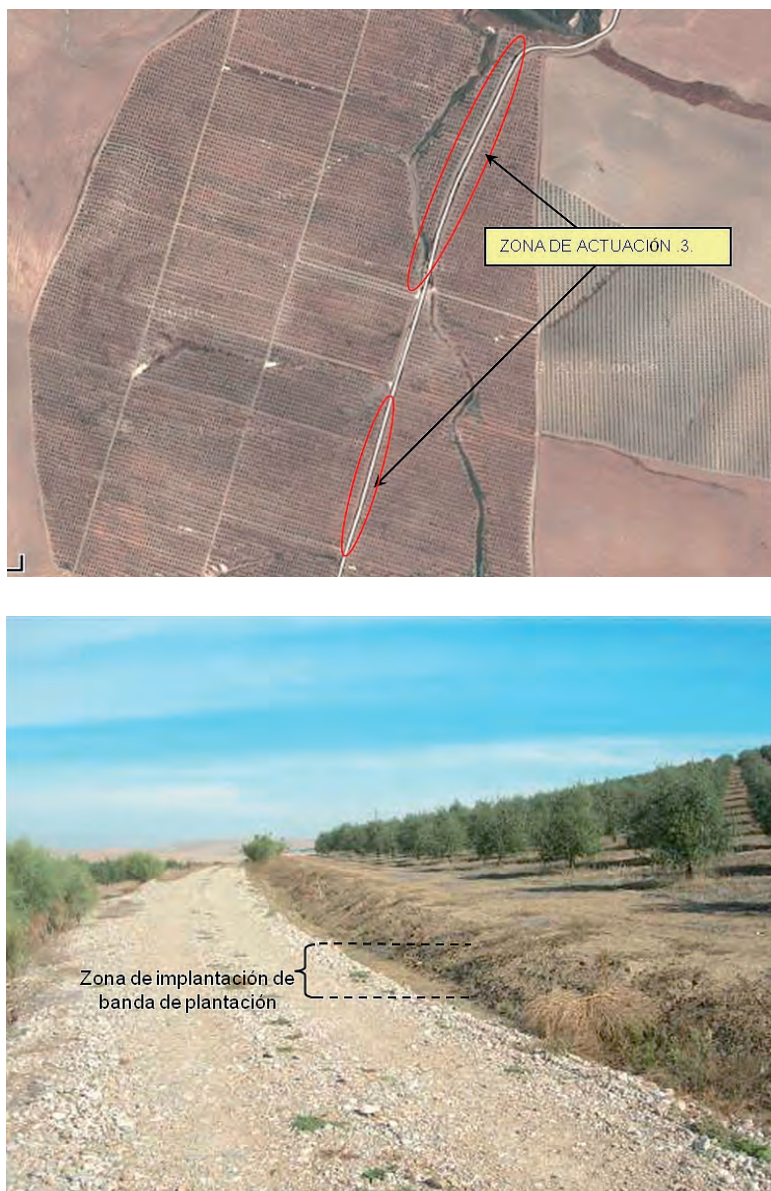
Figura 9.4. Zona de actuación en taludes de borde de camino de servidumbre y accesos a la finca.
