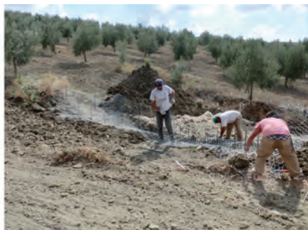
Clavado de barras, colocación de malla y unión mediante alambre
