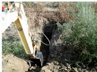
Apertura de zanja
