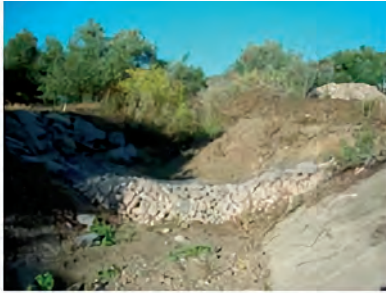
Piedra mallada (sin armadura)
