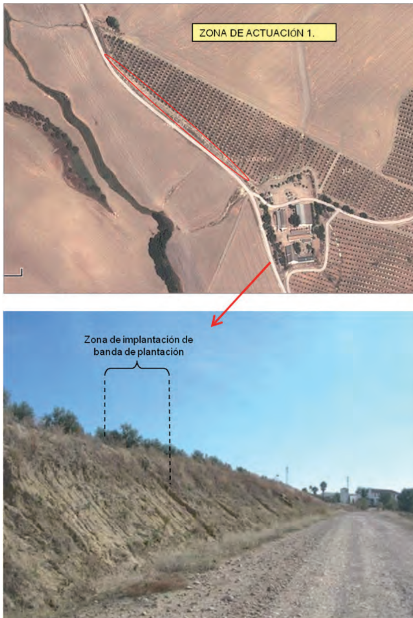
Figura 9.2. Talud de borde de camino público de acceso a la finca.
