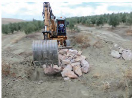
Apertura caja y colocación escollera en cuenco
