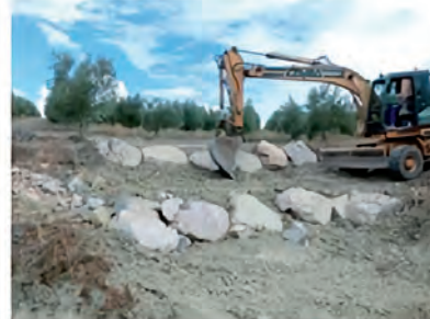
Cordones de escollera
