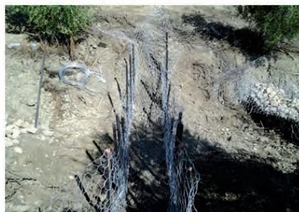
Extendido malla previa relleno
