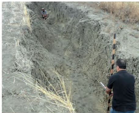
Nivelación mediante cuerda y nivel de burbuja. El operador aguas abajo define la altura del dique y el operador aguas arriba la posición del siguiente dique.
