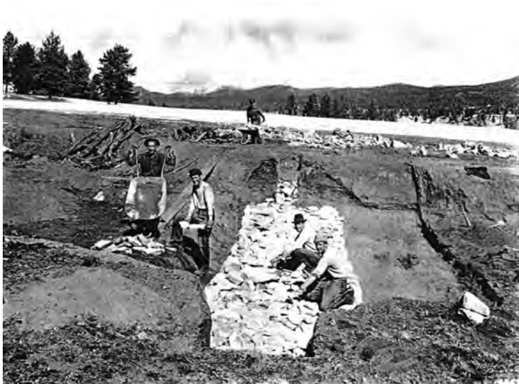
Figura 16. Ejecución de un dique de piedra por el U.S. Civilian Conservation Corps en 1939. Obsérvese en el centro de la imagen el anclado de la estructura a la base de la cárcava (~ 0.3 m) y a los taludes (~ 0.6 m) y a la derecha caja para el cuenco de disipación. El traslado de la piedra a pie de dique se realizaba con carretilla. Imagen tomada de Heede (1960).
