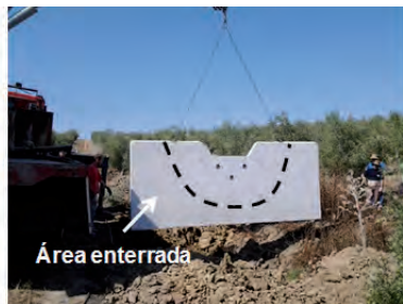
Colocación de placa mediante camión pluma
