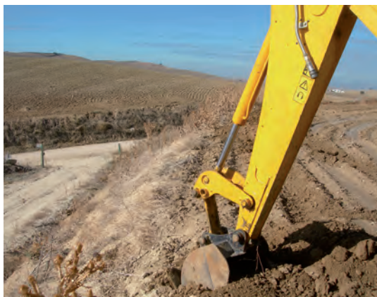
Figura 9.9. Apertura de hoyo con retroexcavadora mixta para árboles de gran porte.
