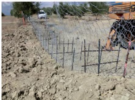
Malla preparada para vertido de bolo
