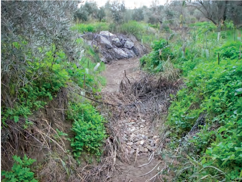
Figura 39. En primer plano, dique de piedra mallada colmatado en una cárcava en olivar. El elemento más visible es el cuenco de disipación. El tramo restaurado aparece tras tres años de la actuación como totalmente estabilizado y la vegetación tanto espontánea como plantada en pleno crecimiento. Obsérvense a los dos lados los tubos protectores verdes de los pies plantados.
