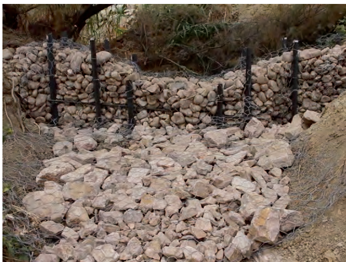
Dique de empalizada doble con bolo y piedra angular en el cuenco.
