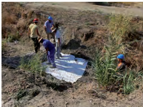
Extendido de malla
