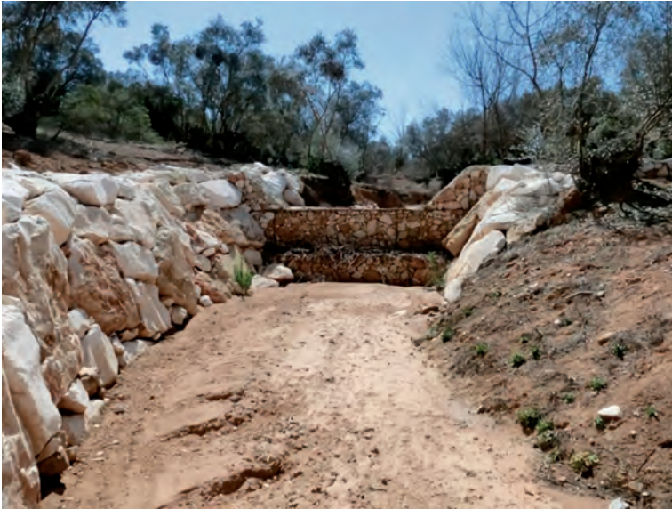
Figura 20. Vista de dique de gavión con cuenco de disipación enterrado por la cuña de sedimentación del dique aguas abajo con espaciamiento definido por el criterio de nivelación ( c = 100\% ). Obra realizada por Tragsa en la provincia de Córdoba.
