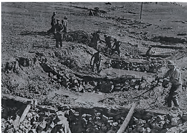
Figura 1. Imagen de la restauración de una cárcava mediante diques de retención y plantación de sauce en el Colorado Front Range (EEUU) en 1933-1934. La década de los años 30 marca el inicio de la edad de oro de la conservación de suelos en este país. Desafortunadamente, en la actualidad la preocupación social por la erosión de suelos ha disminuido notablemente. Imagen tomada de Heede (1960).
