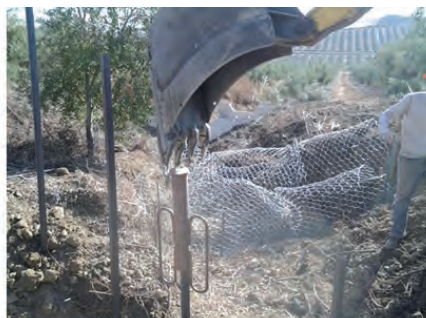
Hincado con cazo e hincapostes
