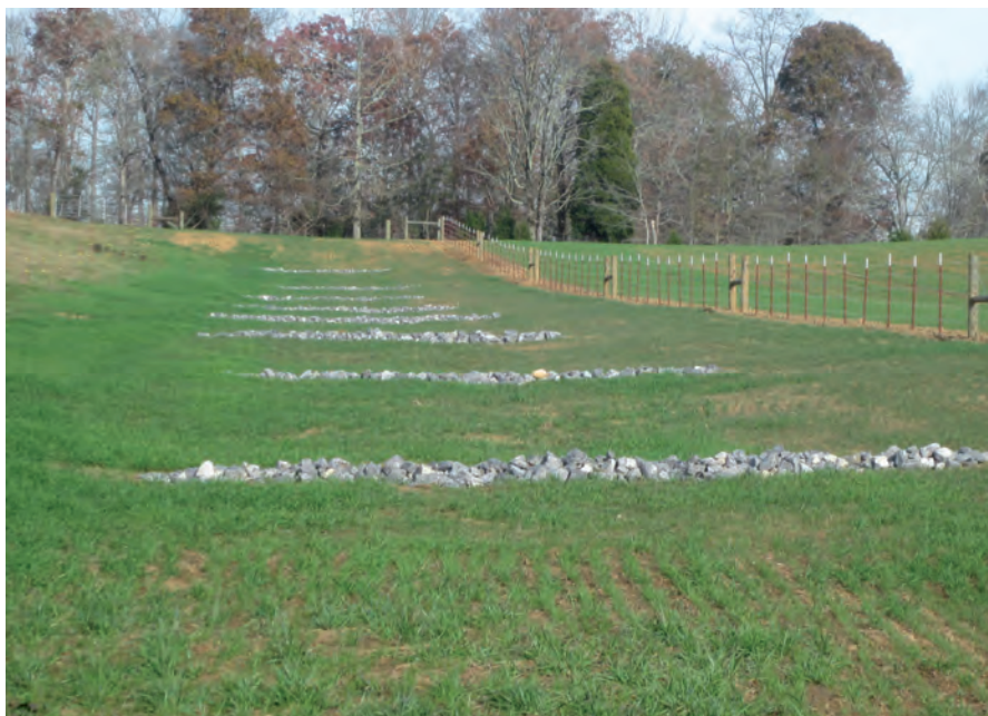
Figura 28. Ejemplo de canal vegetado con cordones de piedra para reducir la velocidad de la escorrentía. Cortesía del Soil Conservation District del Condado de Blount, Tennessee.
