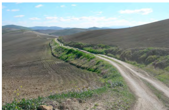
Figura 66. Camino rural con taludes y bordes anchos.
