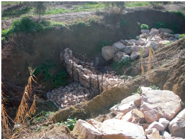
Dique de empalizada simple con piedra angular
