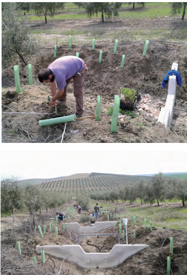
Figura 9.20. Labores de plantación y colocación de protectores en los márgenes del tramo corregido. Obsérvese la ubicación de las dos líneas de plantación. La restauración con diques de retención fue realizada en el verano del 2013.
