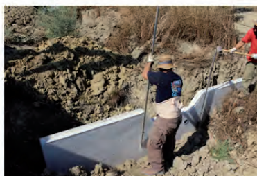
Preparación e hincado de pernos de refuerzo
