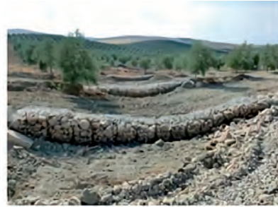
Piedra mallada (con armadura)
