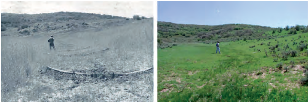
Figura 36. Comparación del estado de una vaguada vegetada con obstáculos el momento de su ejecución (1964) y cuarenta años después (2004). Tomada de Weinhold (2004).
