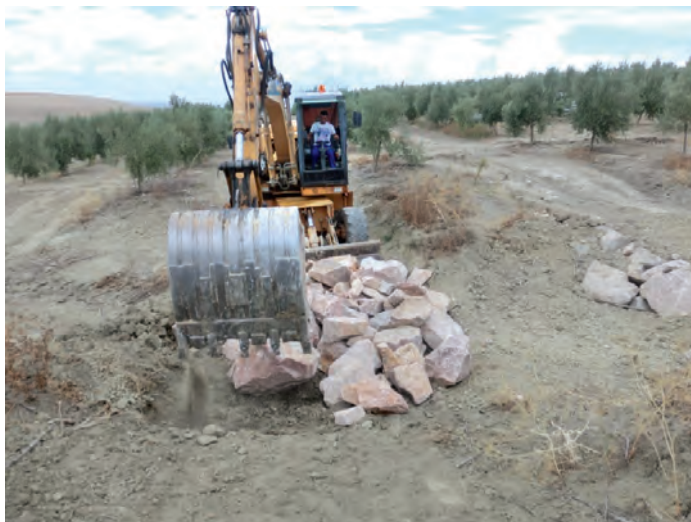
Colocación de escollera en cuenco de disipación.
