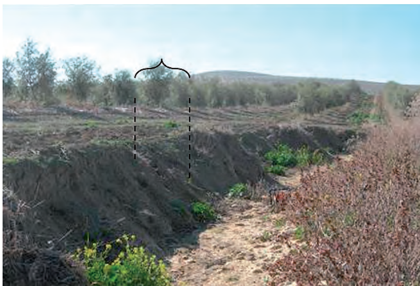
Figura 9.6. Zona de actuación en talud en margen de cárcava.
