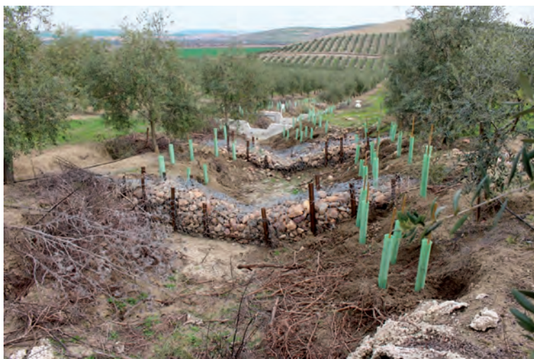
Figura 38. Sedimentación en diques de doble empalizada en el primer otoño tras su implantación en una finca de olivar.
