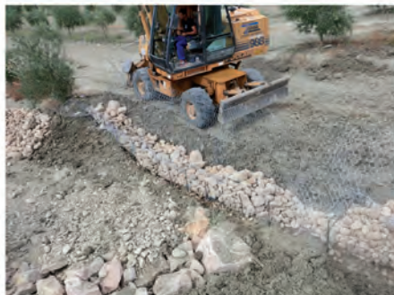
Llenado de dique mediante bolo
