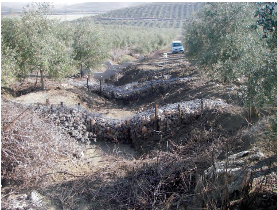
Figura. 9.18. Imagen de la restauración mediante diques de retención, en dirección aguas abajo. Diques de doble empalizada en primer término y diques de placas de hormigón al fondo. Obsérvese la sedimentación incipiente, 4 meses después de la finalización de la obra.
