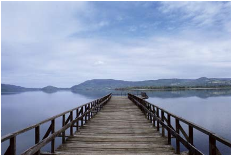
Muelle de Huillinco Huillinco Wharf 40 / 4E Fecha: anterior al terremoto de 1960
