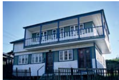
167 Casa corredor. Quellón. 3F
