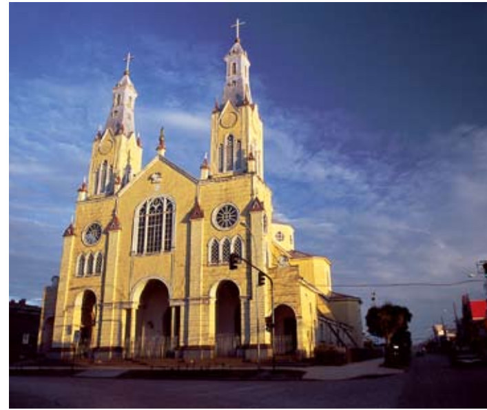
Iglesia de Castro, secuencia de colores. De izquierda a derecha, década del 70, año 1989-90 y pintura del año 2000. The sequence of colours in the Church of Castro. From left to right, during the 1970s, 1989-90 and paint added in 2000.
