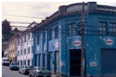
232 Conjunto de hormigón en pasaje Schwerter. Puerto Montt. 2A
