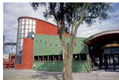
233 Terminal portuario. Arq. L. Berg. Puerto Montt. 2A
