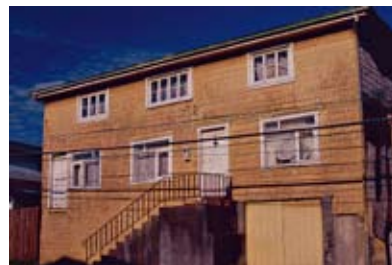
221 Casa con escalera. Puerto Montt. 2A
