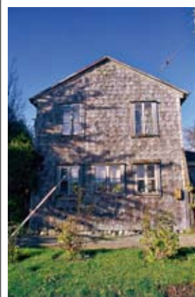
208 Casa pórtico. Chacao. 3B
