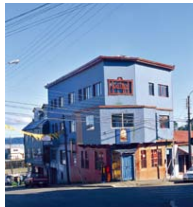
202 Edificio Cobus. Ancud. 3L
