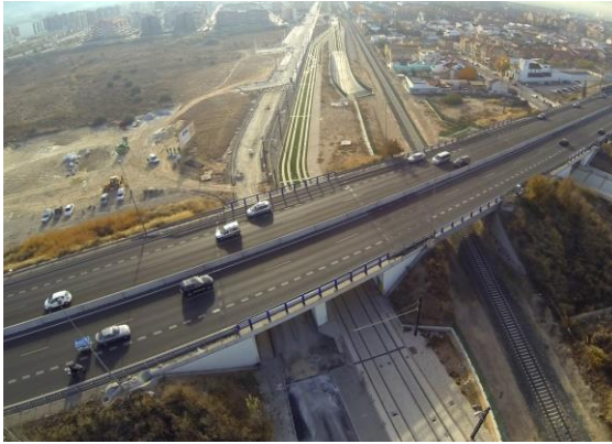
VISTA, PASO INFERIOR BAJO LA AUTOVÍA A-44
