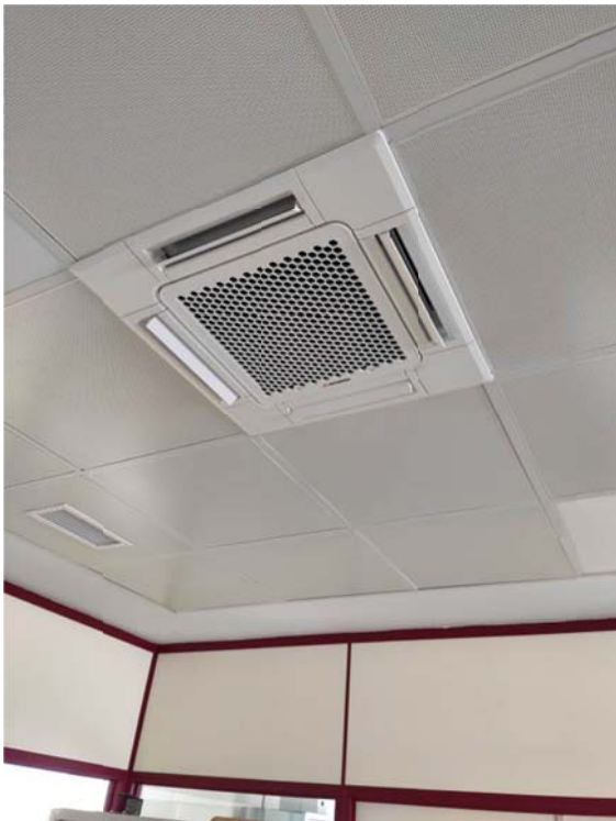
Fotografía N° 15: unidad de climatización interior tipo cassette, para equipo de expansión directa, de nueva instalación.
