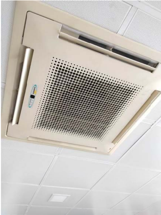
Fotografía N° 15: unidad de climatización interior tipo cassette, para equipo de expansión directa, de nueva instalación.
