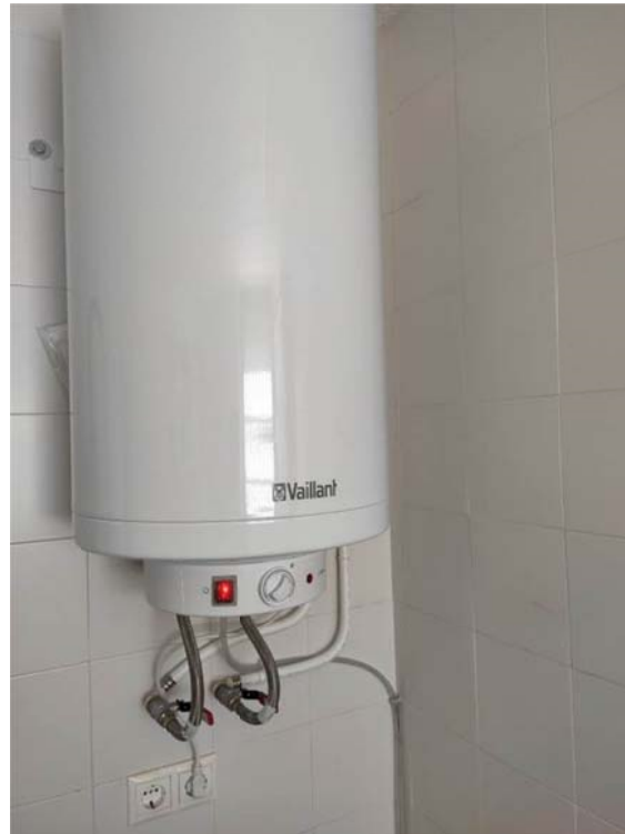
Fotografía N° 08: Termoacumulador eléctrico.
