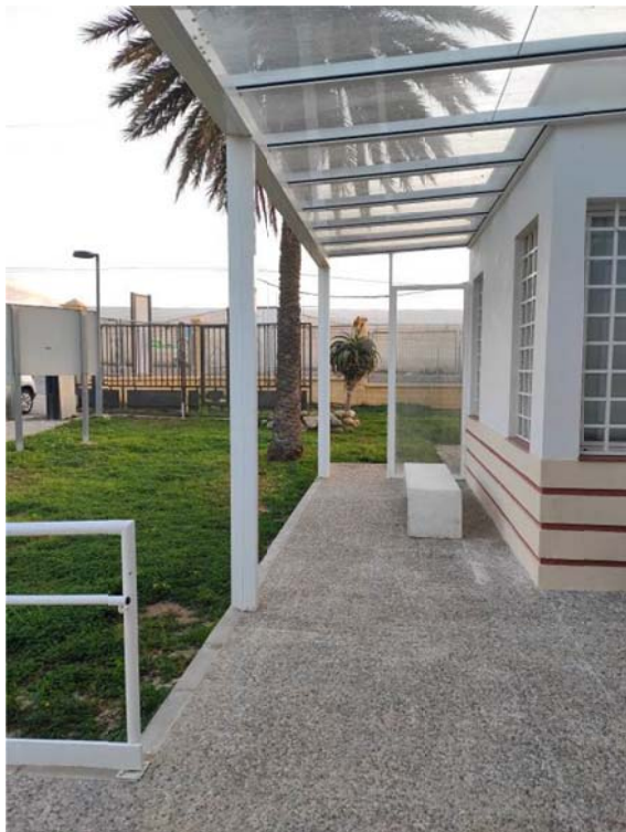
Fotografía Nº 03: Marquesina de acceso.
