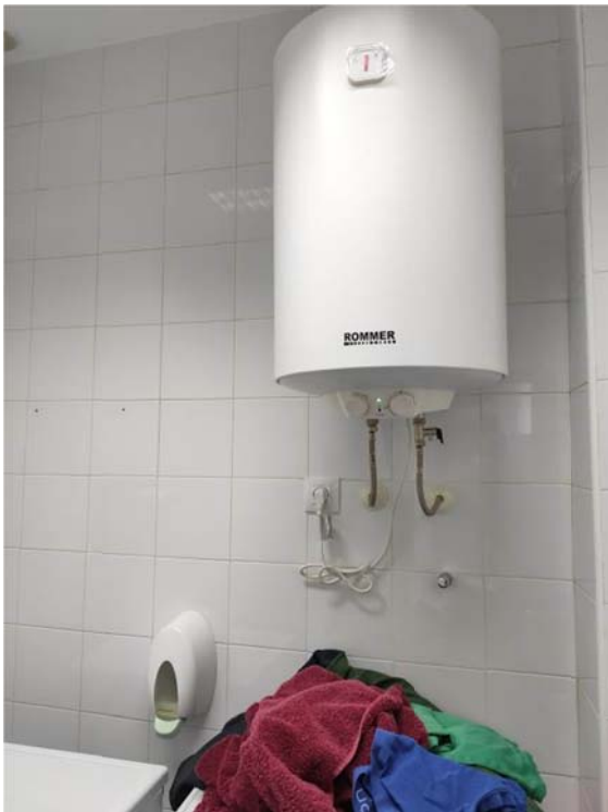
Fotografía N° 07: Termoacumulador eléctrico en vestuarios, planta primera.
