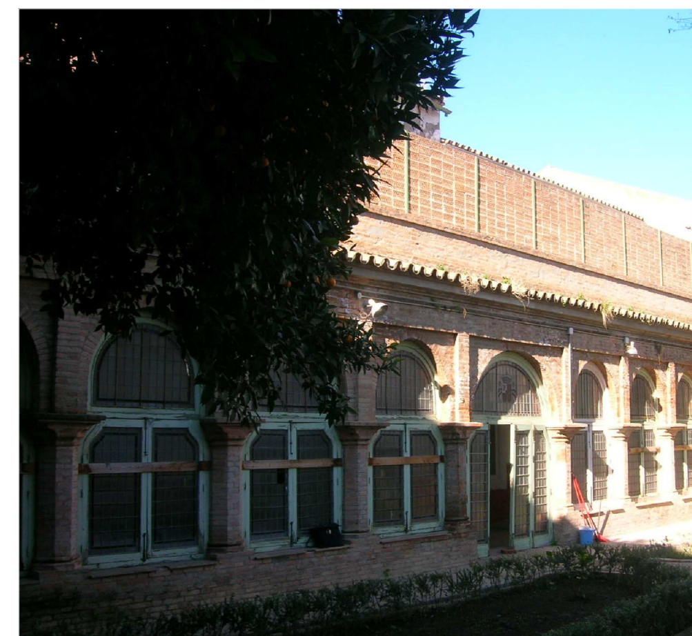
ESTADO ACTUAL PATIO INTERIOR. TERRAZA PLANTA ALTA SIN USO
