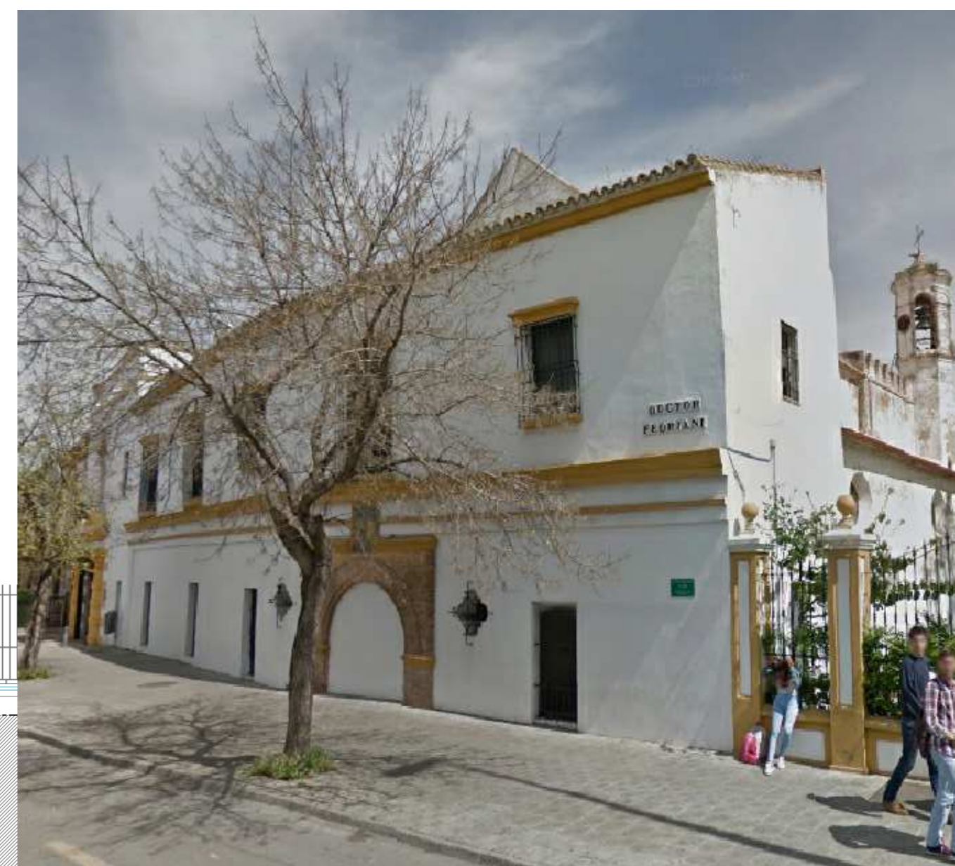
ESTADO ACTUAL. PUERTA CLAUSURADA Y ENTERRADA
