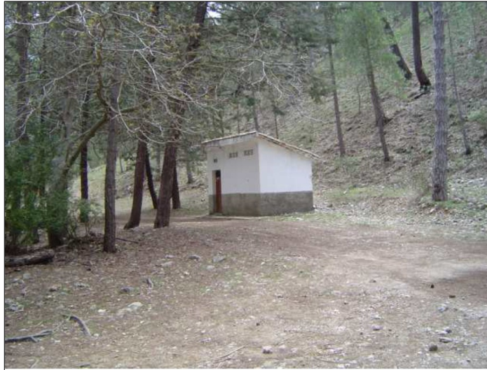
ALMACÉN GRUPO ELECTRÓGENO
