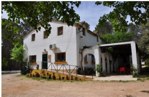
EDIFICIO DE SERVICIOS GENERALES
