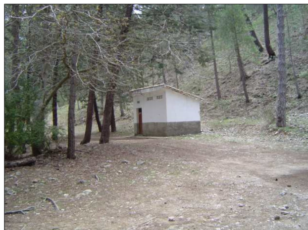
ALMACÉN GRUPO ELECTRÓGENO
