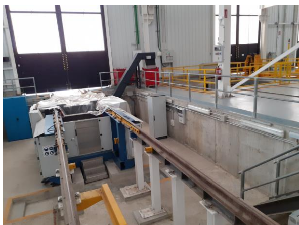
Ilustración 11. Iluminación zona Taller
