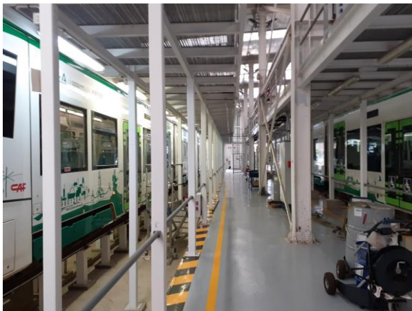
Ilustración 9. Iluminación zona Taller
