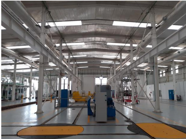
Ilustración 7. Iluminación zona Taller
