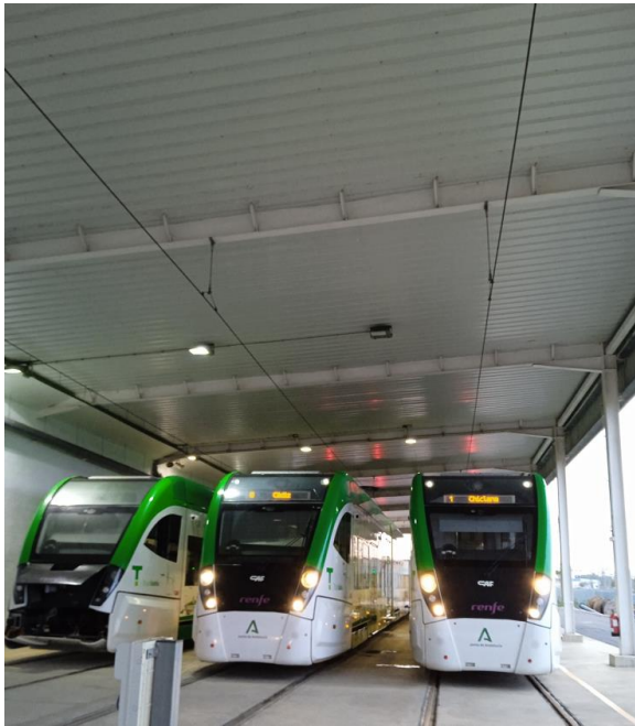
Ilustración 3. Proyectores iluminación zona de cocheras
