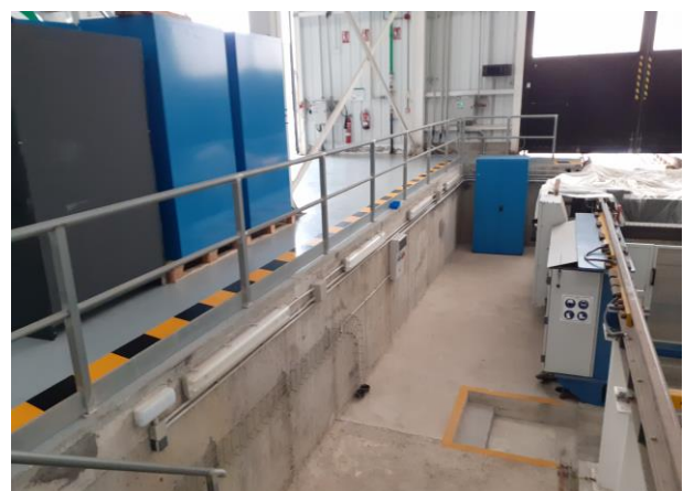
Ilustración 12. Iluminación zona Taller
