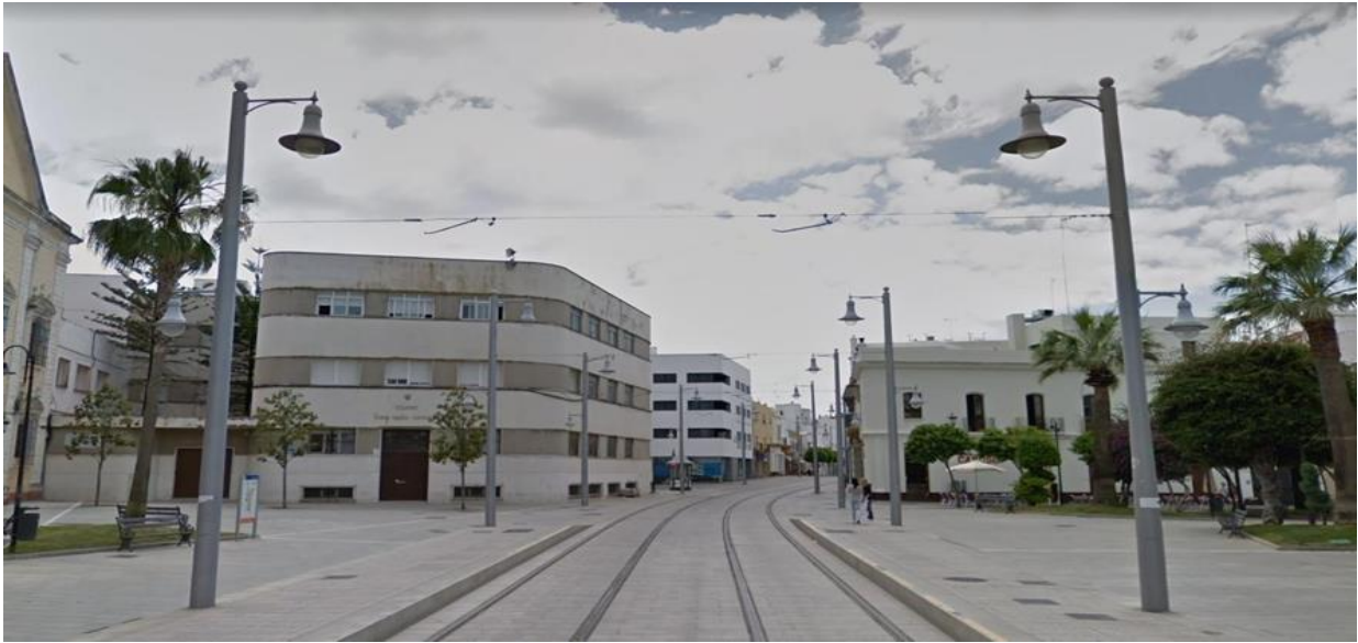
Ilustración 3 Luminaria doble vial y acera
