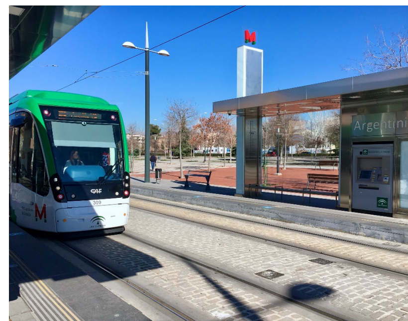
Figura 1 Marquesina de Parada doble anden
