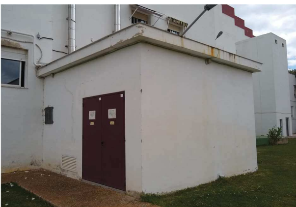
Sala de calderas
