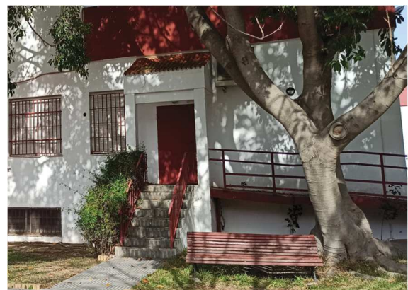
Sala de calderas
