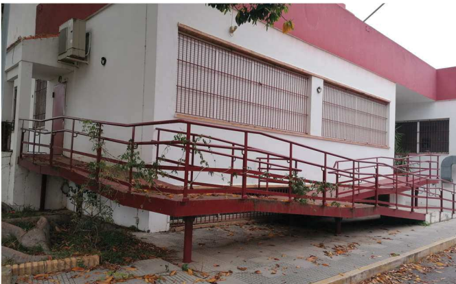
Sala de calderas
