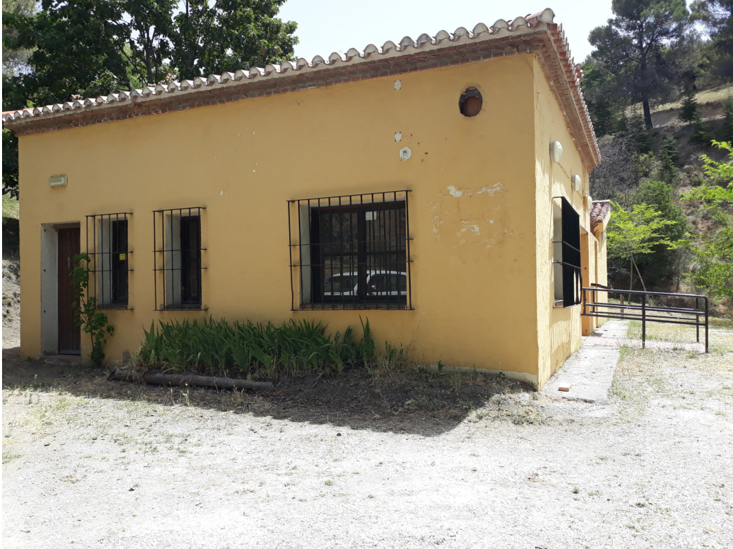
1. Vistas de entrada cocina y bar
