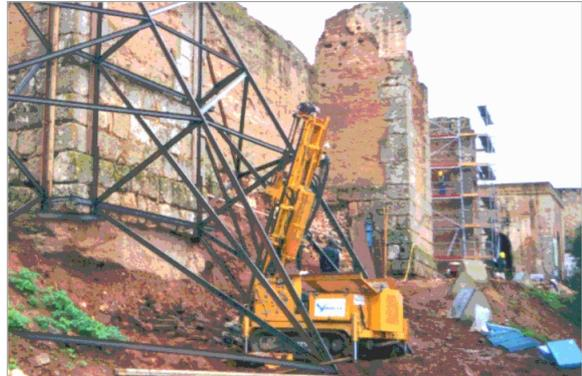
Las perforaciones se realizan con una sonda de avance hidráulico montada sobre camión o con motricidad autónoma (según las necesidades y características del estudio) dotada de castillete o torre de sondeo y bomba de lodos.
