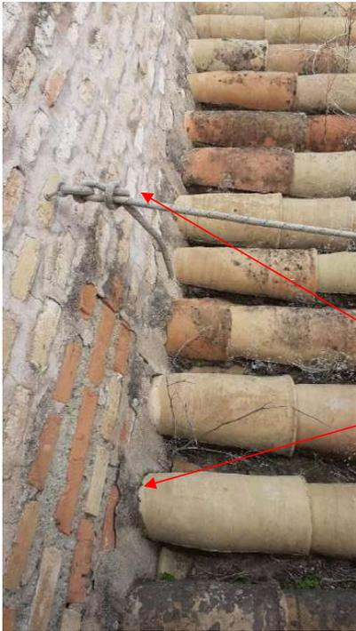
Fisuraciones en encuentro con el muro y el propio muro
