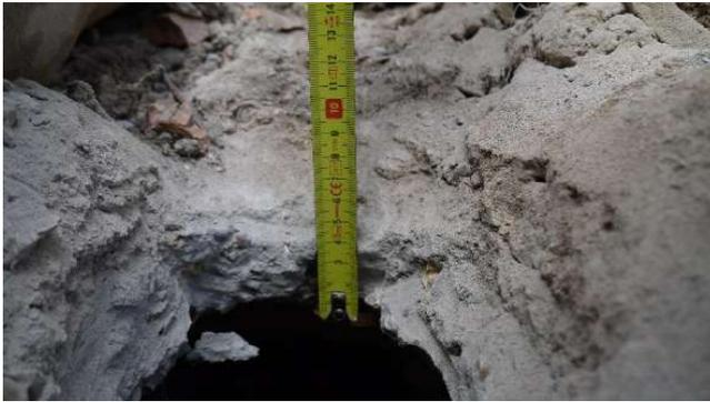
Espesor de 7 cm de capa de hormigón existente sobre rasillones
