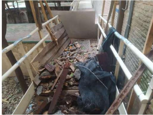
En una inspección realizada desde la terraza donde se sitúan los equipos de climatización (planta tercera) se ha podido comprobar la abundante presencia de vegetación con carácter general en los canales de evacuación del tejado de esta galería y, especialmente, en el tramo donde se ha producido el desprendimiento del alero.
