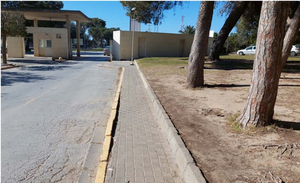
Foto nº 8. Zona en la que se va a ampliar la parada situada junto a la salida del Hospital
