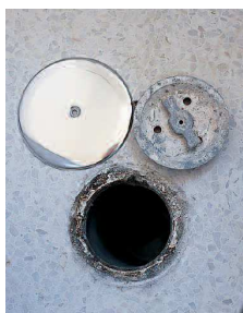
10. BOTE SIFÓNICO CON TAPA DESMONTADA.
