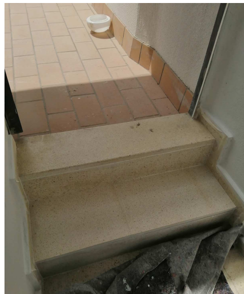
Peldaños de acceso a cubierta plana transitable
