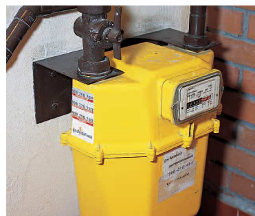
21. CONTADOR INDIVIDUAL Y LLAVE DE CORTE.
