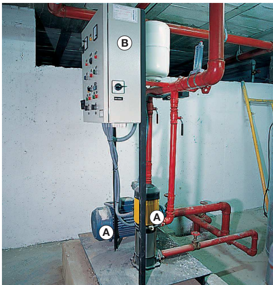
8. FRENTE DEL CUADRO DE CONTROL, MANDO Y PROTECCIÓN DEL GRUPO DE PRESIÓN DE LAS BIE.
