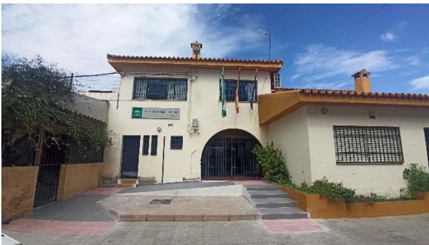
Acceso al edificio
