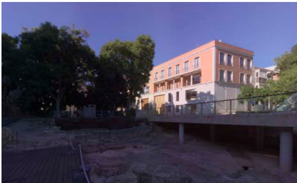
Perfil en el borde de la explanada y vista de la zona de las pilas
