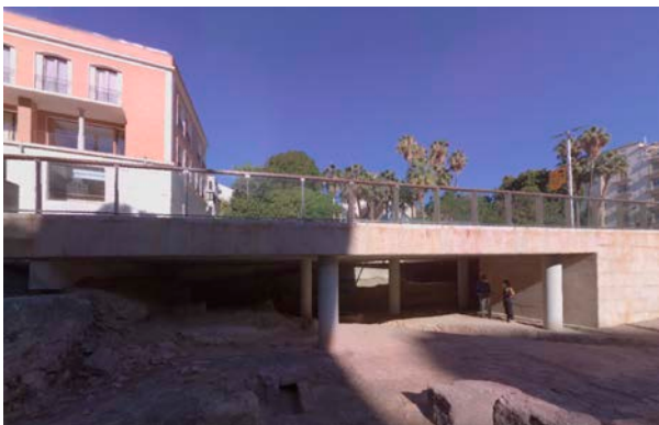
Bajo calle Alcazabilla. Zona de pilas
