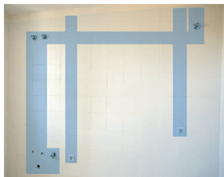
23. Bandas por donde discurren las instalaciones. Cocina.
