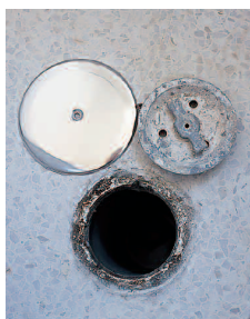
10. BOTE SIFÓNICO CON TAPA DESMONTADA.
