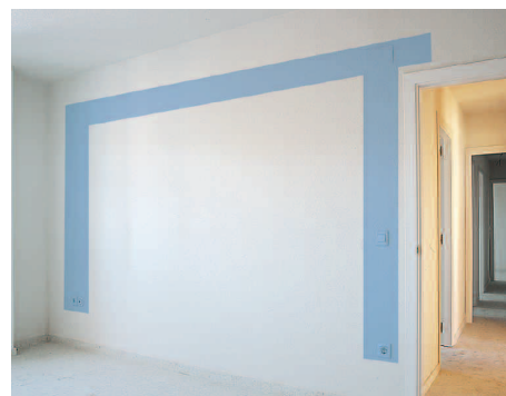
24. Bandas por donde discurren las instalaciones. Salón.
