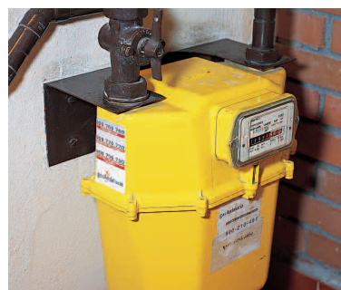
21. CONTADOR INDIVIDUAL Y LLAVE DE CORTE.
