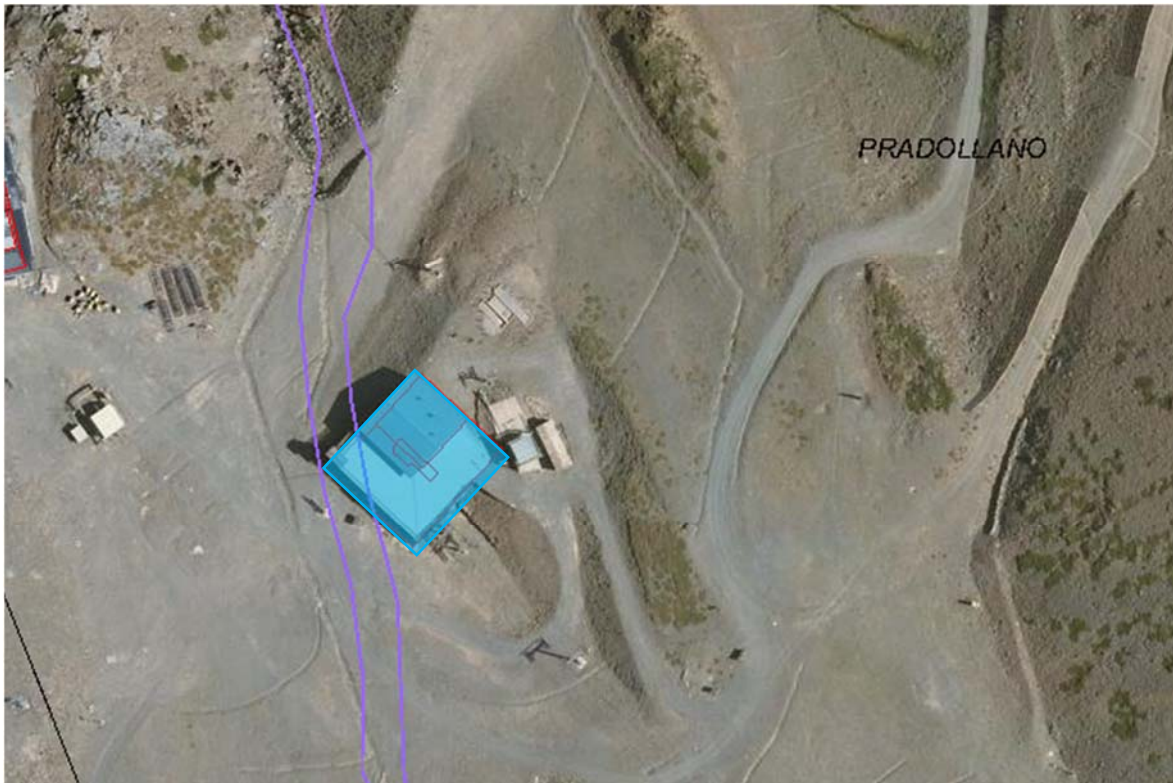
Ilustración 2. Situación Edificio Telesilla Stadium Inferior
