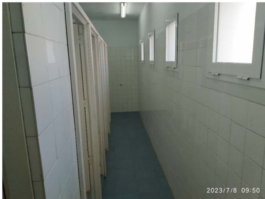
Ventanas a desmontar y revestimientos a demoler
