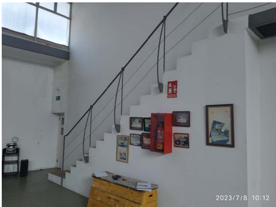
Escalera a demoler
