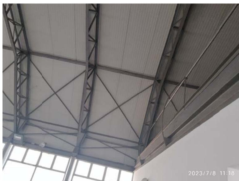
Ventanales y estructura
