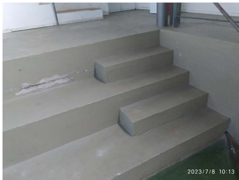
Fisuras hormigón
