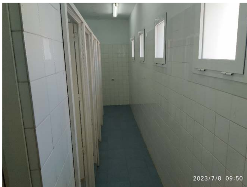
Ventanas a desmontar y revestimientos a demoler
