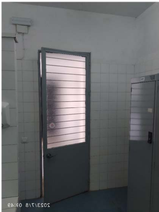
Acceso exterior a vestuarios
