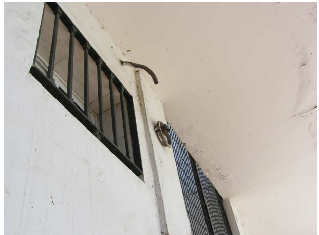
Oxidación de rejilla de acceso y ventilación del sótano
