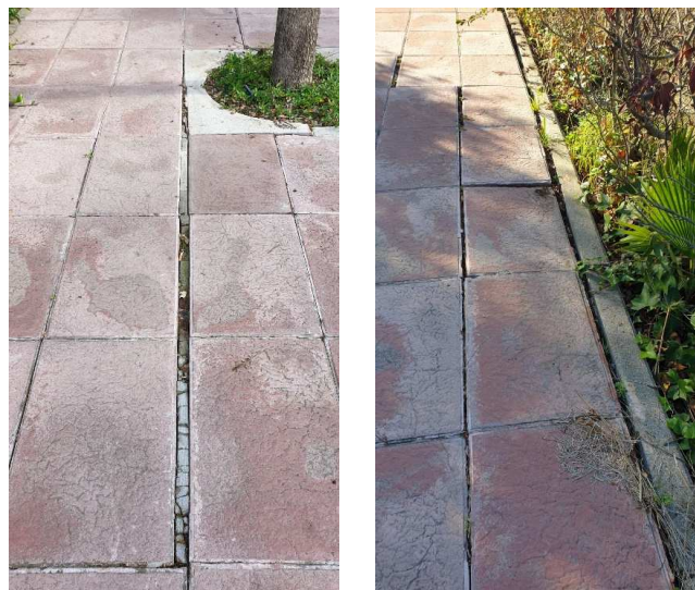
Detalle del pavimento del paseo peatonal
