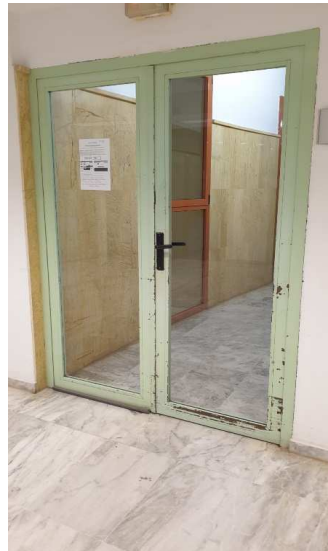
Puerta metálica sótano 1.
