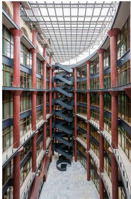
Galerías de mantenimiento en planta impares.
