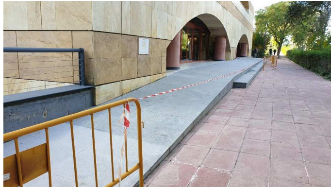
Rampa itinerario accesible hacia sala de Anexo Norte
