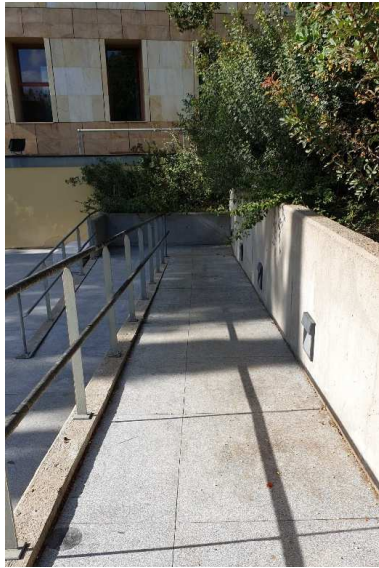
Rampa itinerario accesible acceso salones de Actos
