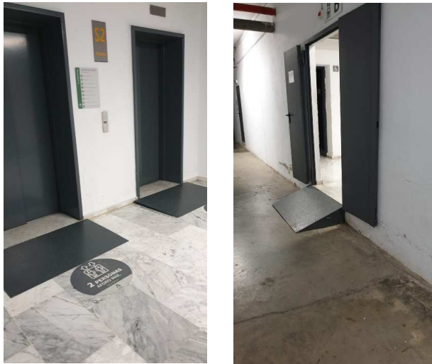
Rampas provisionales en sótano 2
