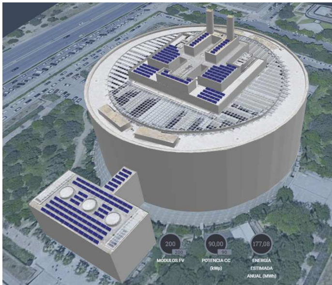
Implantación de instalación fotovoltaica con producción de 90 kWp.
