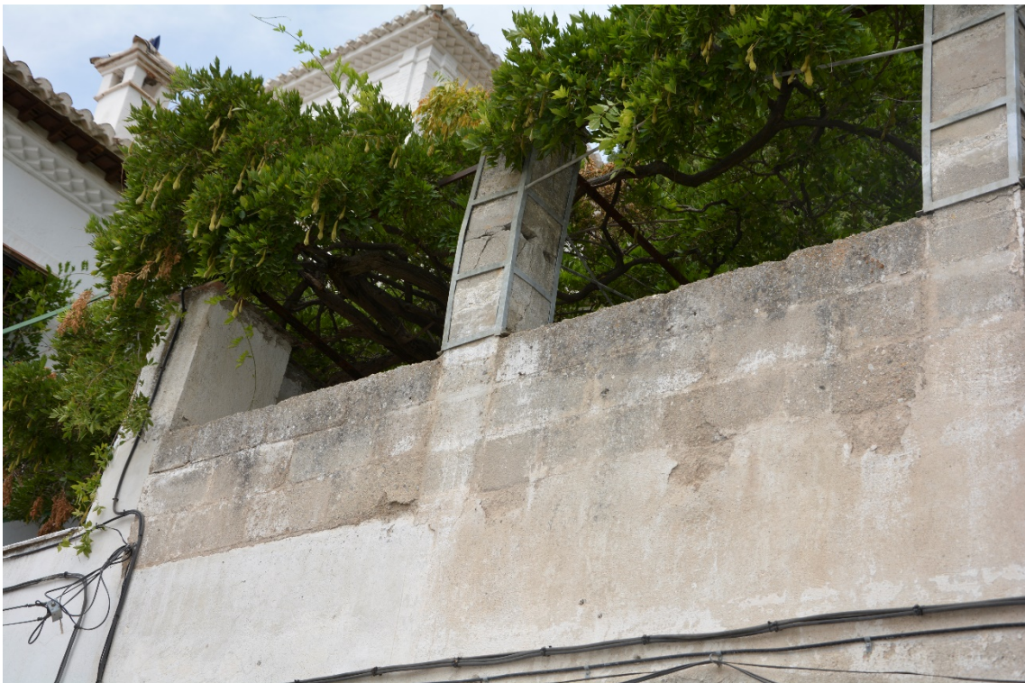
Pilares que dan a la calle Aire Alta
