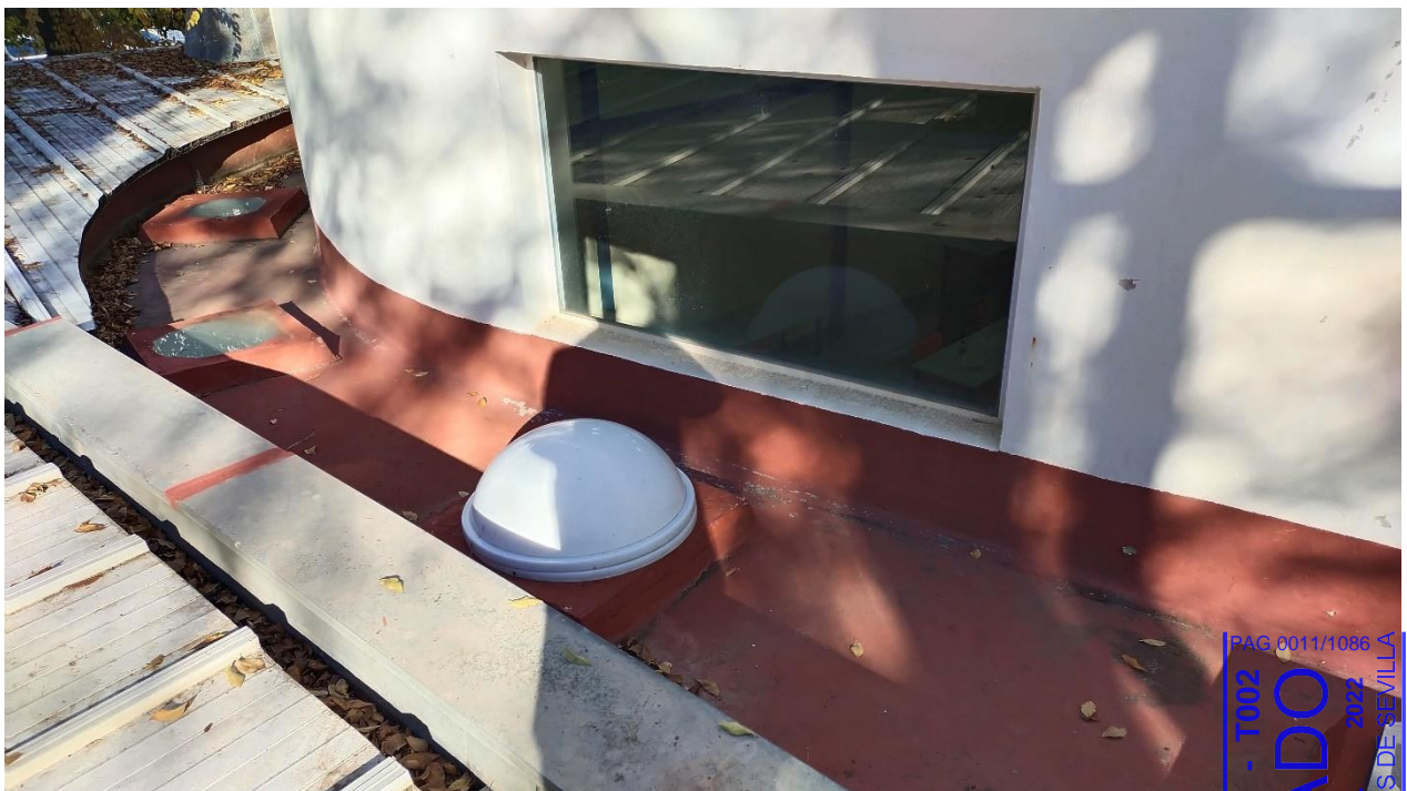
Imagen de ventana a sustituir
