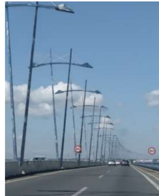
Fotografía 4: algunas señales verticales adosadas a los báculos.
