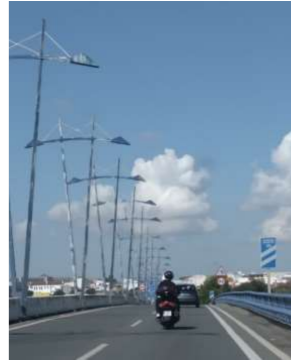
Fotografía 11: nótese cómo el gálibo queda restringido por la forma de los báculos.
