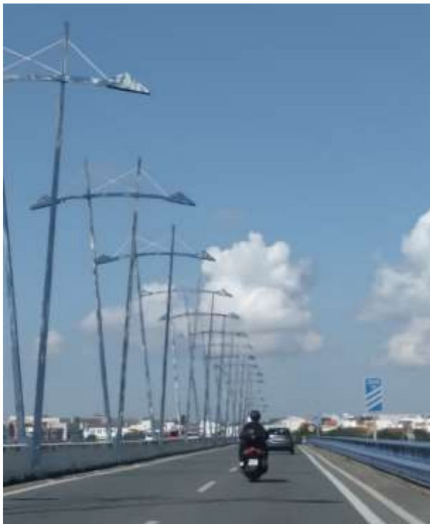
Fotografía 10: se limpiará y repintará las barreras centrales y las laterales.
