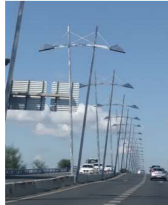
Fotografía 3: pórtico cerca del estribo de Huelva.
