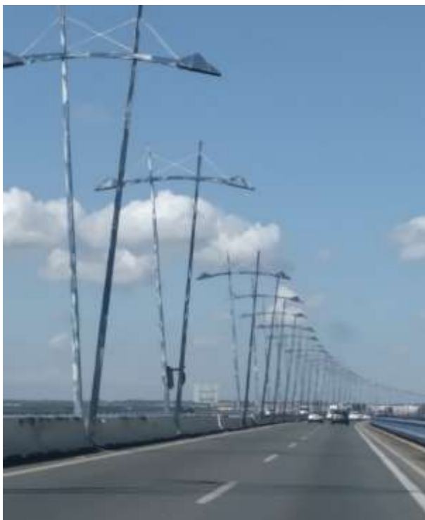
Fotografía 5: nótese el estado deficiente de la pintura en barreras centrales.
