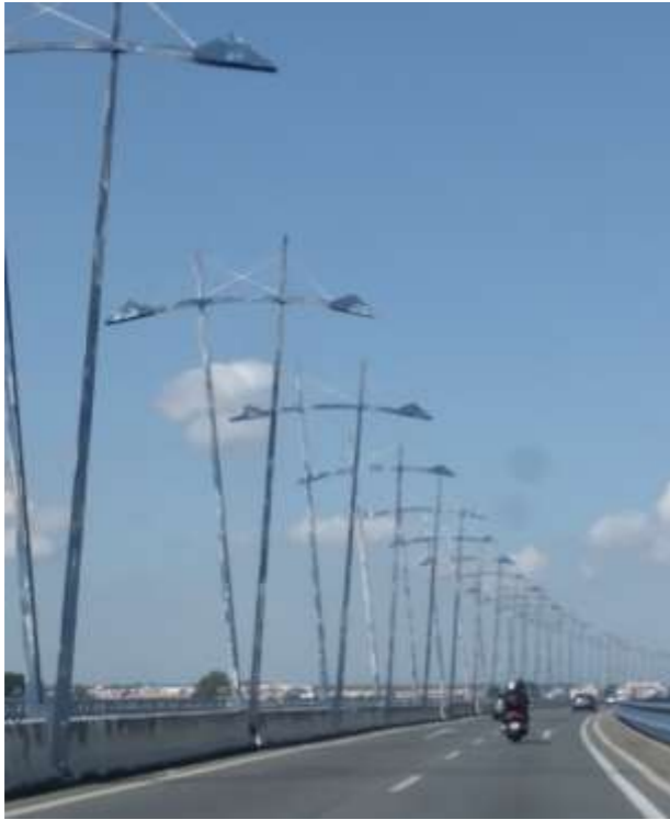
Fotografía 9: carriles con anchos según detalles en planos.
