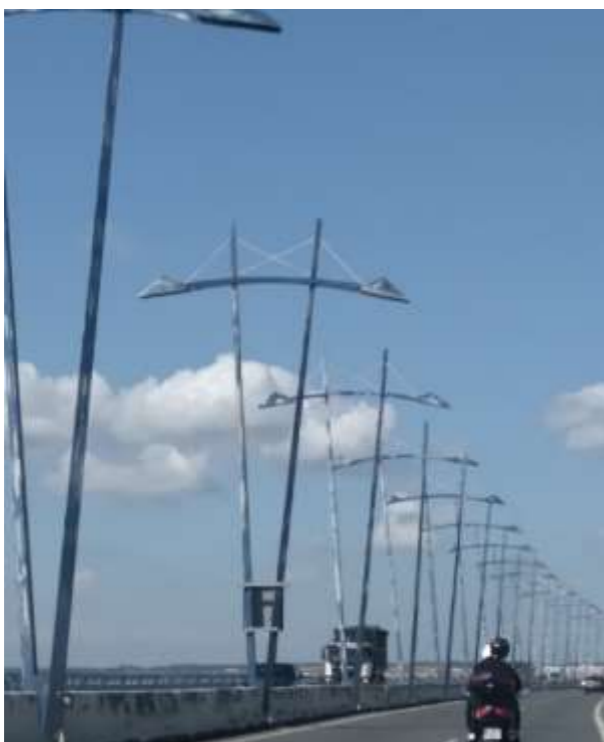
Fotografía 6: señalización vertical adosada a báculos existentes.
