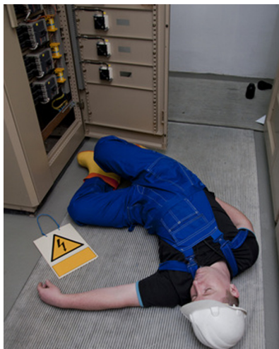
Figura 16. Contacto eléctrico directo
