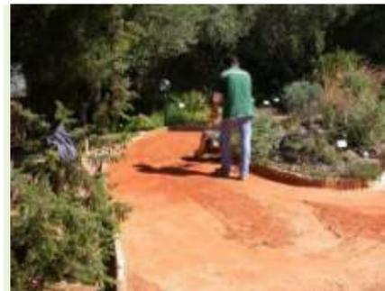
En el Jardín Botánico de **SAN FERNANDO** se ha procedido a la compactación de suelo de los viales. Eliminación de cárcavas mediante el escarificado del suelo en la zona donde se presentaban o este se encontraba desagregado (arenal), adición de arena con cal, mezcla con sustrato anterior, riego y pase de compactadora manual.
