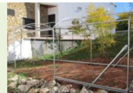
En Jardín Micológico **LA TRUFA** Obras de adecuación y construcción de un invernadero. Se ha acondicionado el terreno disponible, y se han instalado la estructura, mediante cimentación y soldadura. El invernadero está construido en acero galvanizado.
