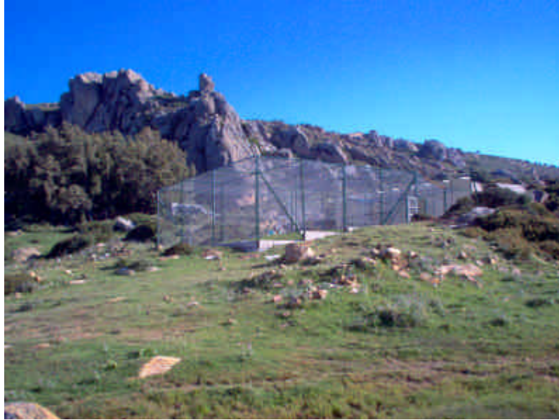
Fotografía 2.- Fase de construcción del aviario. Abril 2004.
