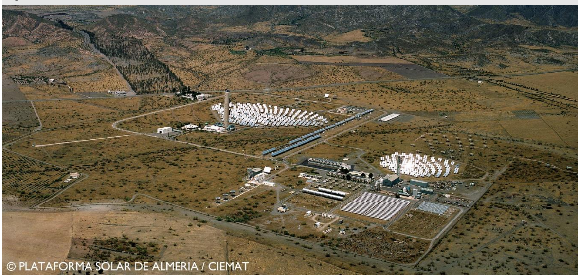
Figura 32. Vista aérea de la Planta Solar de Almería
