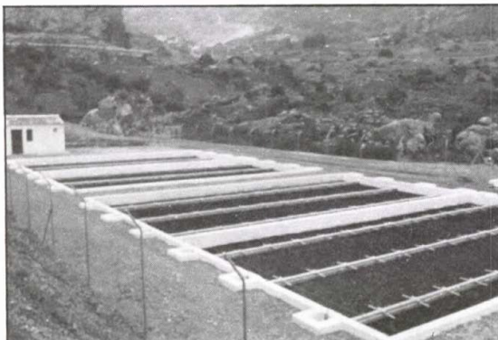
Estación depuradora por lecho de turba en Grazelema.
